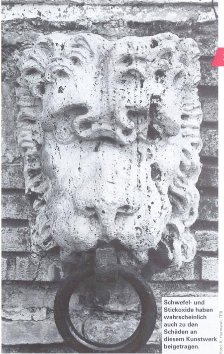
Augenfällige Beispiele für schädliche Einflüsse von Luftschadstoffen sind viele alte Bau- und Kunstwerke aus Sandstein, Marmor und anderen Baustoffen, die stark unter der Einwirkung von sauren Luftschadstoffen zu leiden haben. Weniger gravierend sind die Schäden an Betonbauten. Entsprechend dünn gesät sind denn auch die Artikel zu diesem Thema.
