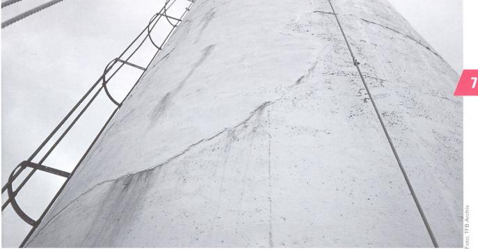
Korrosions- und andere Schäden am Kamin einer Kehrichtverbrennungsanlage. Ursachen: ungenügende Überdeckung, Carbonisierung, Einwirkung von Salzsäure (Chloriden). Schwefel- und stickstoffhaltige Luftschadstoffe dürften nur am Rande für die Schäden verantwortlich sein.
