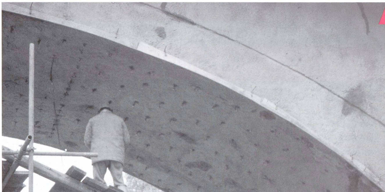
Rasterinjektion zum Füllen von Hohlräumen im Betongefüge einer Brücke.
