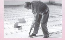
Setzen von zweireihig, paarweise angeordneten Verbundelementen mit einem Setzgerät.
