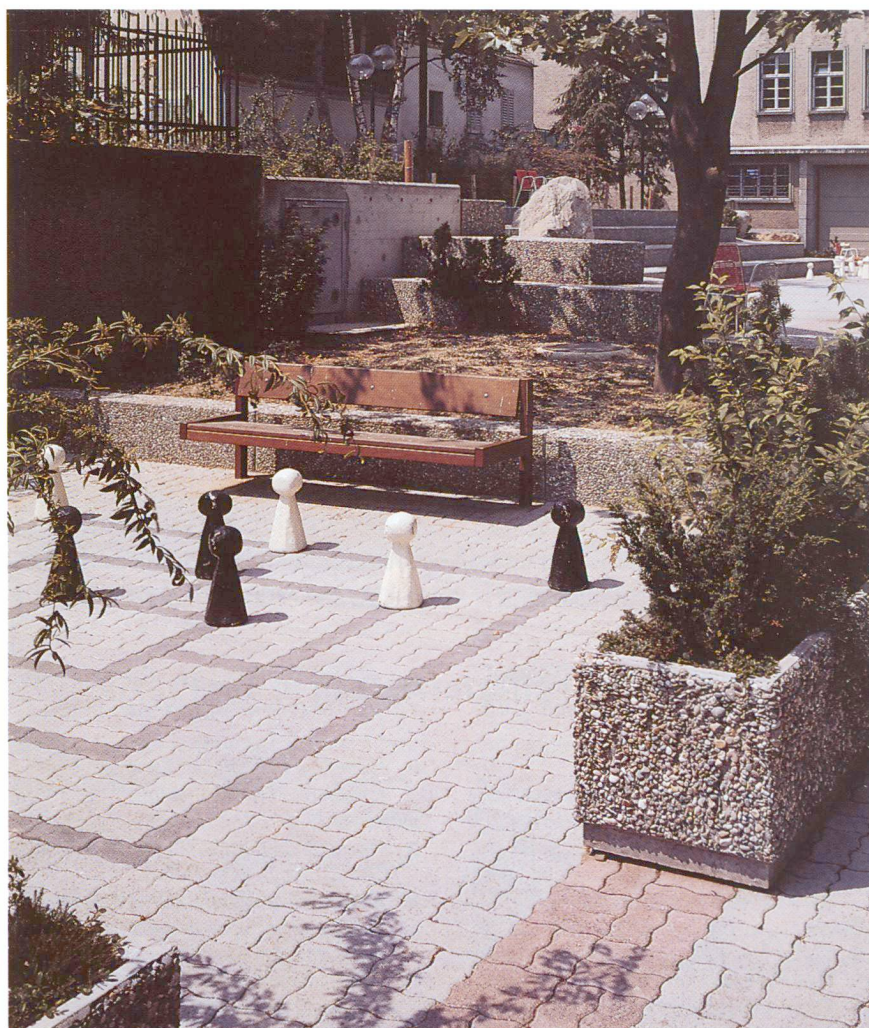
Verbundpflastersteine auf Spielplatz.
