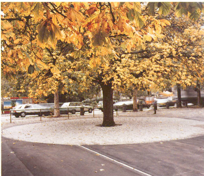
Betonsickersteine sorgen im Wurzelbereich von Bäumen für Wasser- und Luftzutritt.
