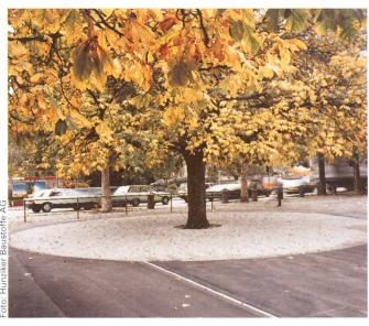
Betonsickersteine sorgen im Wurzelbereich von Bäumen für Wasser- und Luftzutritt.
