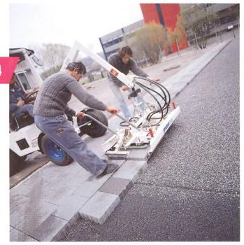
Verlegen von Betonpflastersteinen mit einer Verlegemaschine.
