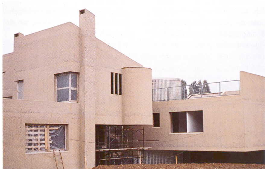
Sandgestrahlter eingefärbter Ortbeton (Italien).
