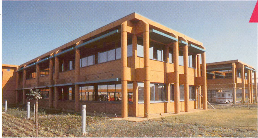
Eingefärbter Ortbeton in Südafrika.
