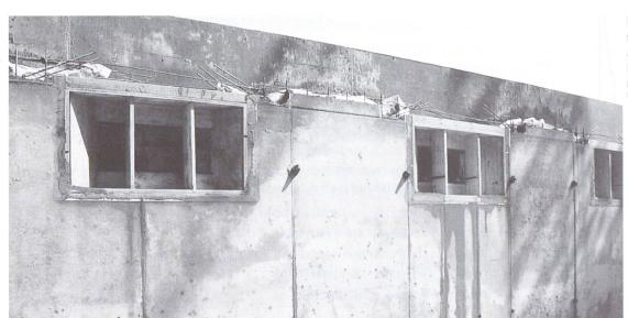
Frisch ausgeschalte Mauer aus CEM-II/A-Lhaltigem Beton.
