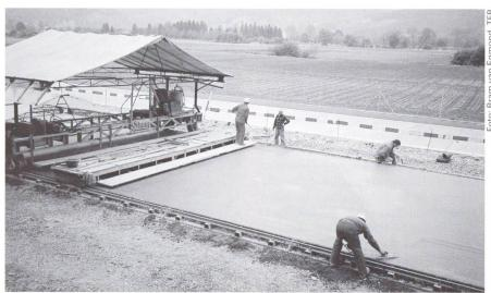
Einbau eines silicastaubhaltigen Strassenbelags aus Recyclingbeton (N 13).
