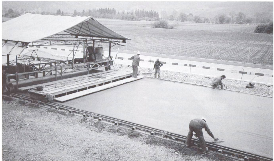
Einbau eines silicastaubhaltigen Strassenbelags aus Recyclingbeton (N 13).
