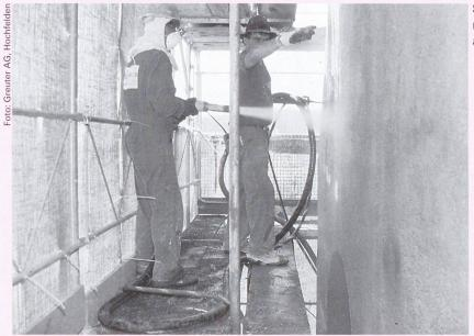
In einer Firma, die seit vielen Jahren Spritzbeton im Trockenspritzverfahren einsetzt, war es lange üblich, dem Spritzbeton etwas hydraulischen Kalk beizugeben, um seine Verarbeitbarkeit zu verbessern. Besonders die Oberflächenbearbeitung, beispielsweise das Taloschie-
