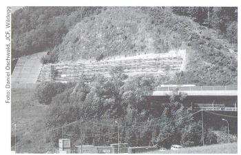
Sanierung der Hangsicherung an der N 2 bei Eptingen – eine weitere Anwendung von hydraulischem Kalk als Zusatzstoff.
