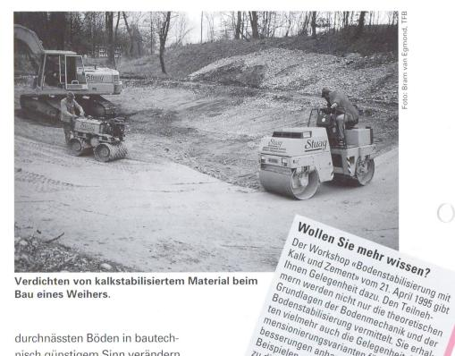
Verdichten von kalkstabilisiertem Material beim Bau eines Weihers.
