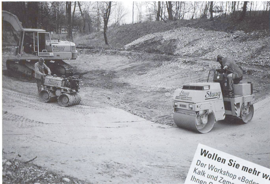
Verdichten von kalkstabilisiertem Material beim Bau eines Weihers.
