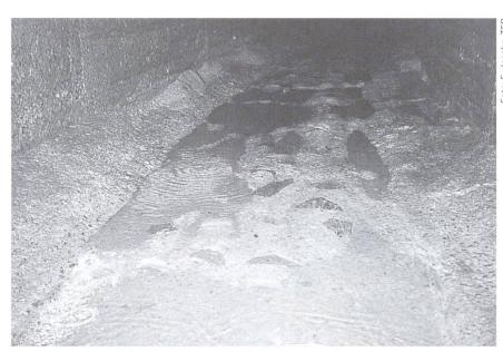
Betonabrasion im Umlaufstollen Runcahez des Kraftwerks Vorderrhein, bei dem als Abrasionsschutz 20 bis 40 cm grosse Natursteine einbetoniert wurden.
