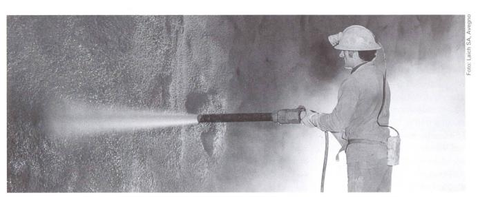
Bei Spritzbetonanwendungen im Tunnelbau wird häufig mit Erstarrungsbeschleunigern gearbeitet.
