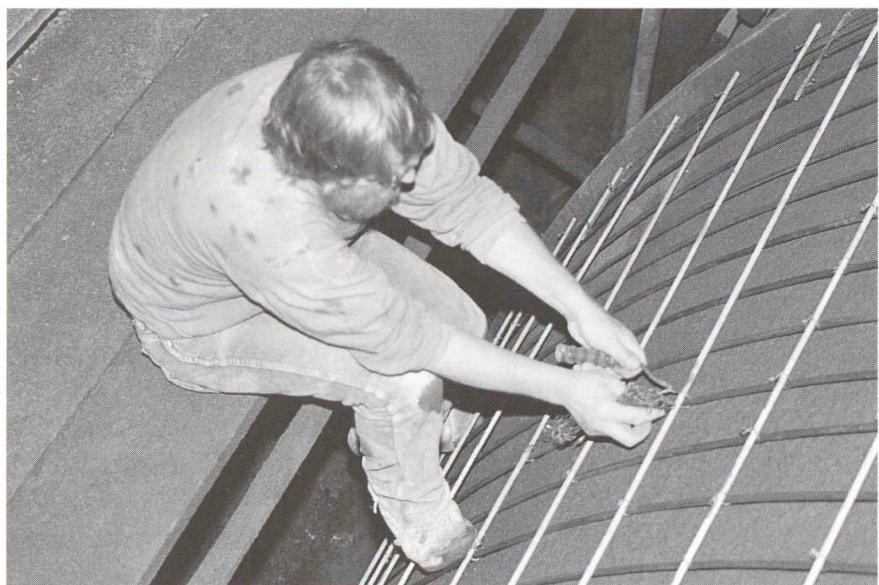
Verlegen der zweiten Armierung.
