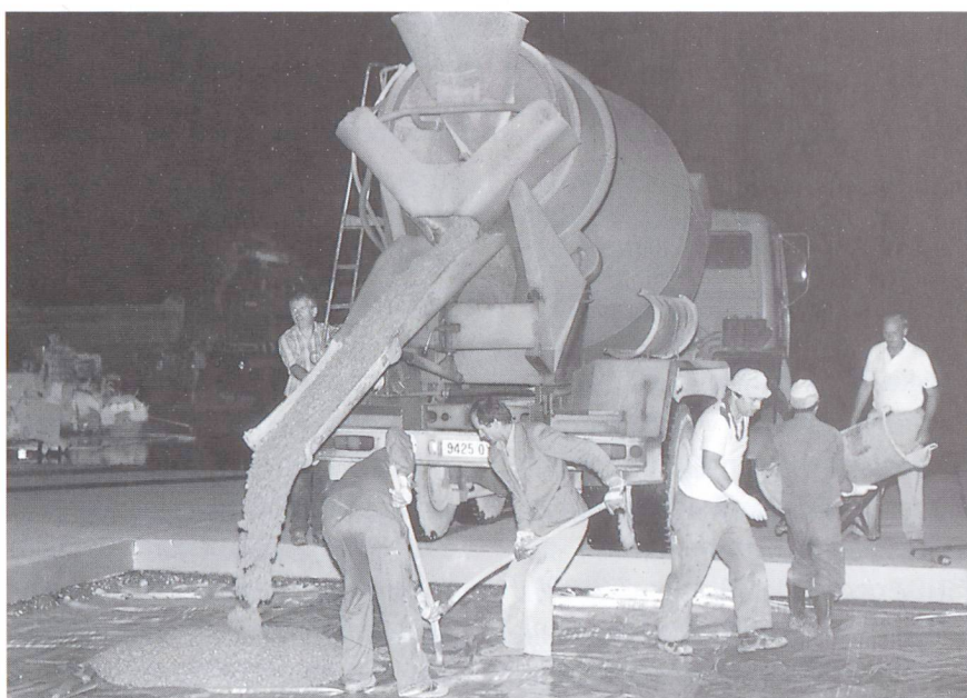
Nächtlicher Einbau von Beton (350 kg Zement, 2,5 % HBV und 0,6 % LP) auf dem Flughafen Basel.
