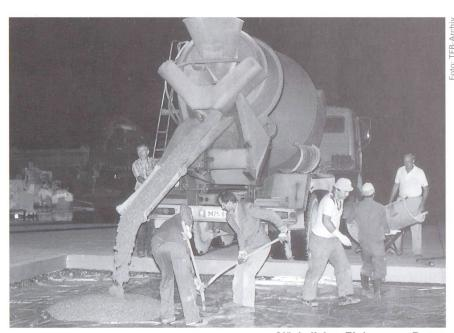
Nächtlicher Einbau von Beton (350 kg Zement, 2,5 % HBV und 0,6 % LP) auf dem Flughafen Basel.
