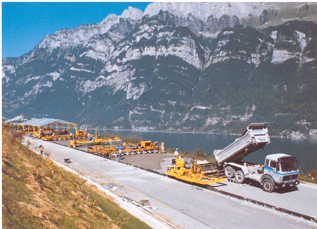
Schienen- einbauzug auf der Walensee- autobahn (N3).
