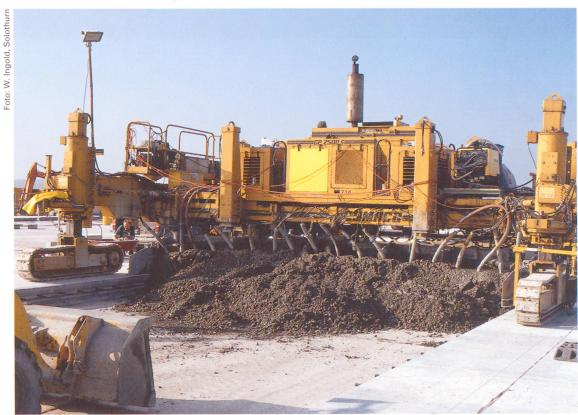
Einbau mit Gleitschalungsfertiger.
