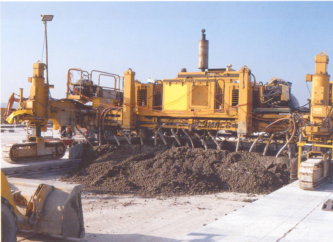
Einbau mit Gleitschalungsfertiger.
