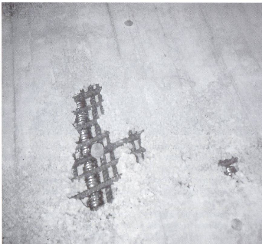
Zu geringe Abstände zwischen den einzelnen Bewehrungsstäben und ungenügende Überdeckung waren die Ursache dieser gravierenden Schäden auf der Unterseite einer Brücke.
