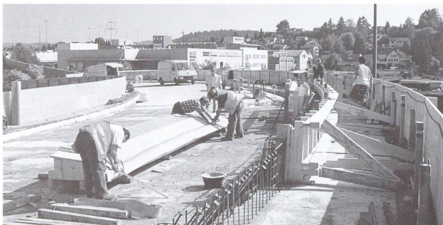
Bespannen von Brüstungselementen mit wasserab-führenden Schalungsbahnen.
