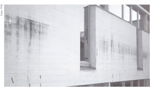
Korrosionsschäden als sichtbare Folgen von ungenügender Überdeckung und schlechtem Randbeton (Carbonatisierung!).
