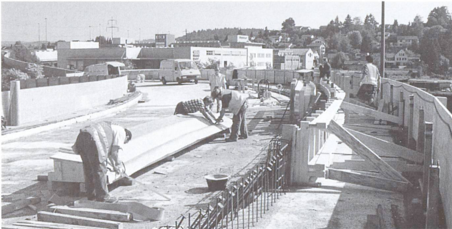
Bespannen von Brüstungselementen mit wasserab-führenden Schalungs-bahnen.
