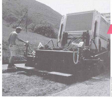
Recyclingmaschine sowie das Verdichten und Nachbehandeln der stabilisierten Tragschicht. Drei Tage nach Baubeginn wurde diese bereits befahren. Sie wurde später mit einer 5 cm dicken Schicht aus dem abgefrästen alten Belagsmaterial sowie 8 cm HMT 22N und 5 cm AB 11N überdeckt.
