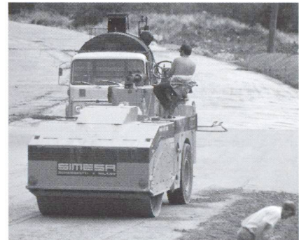
Verdichten mit Vibrationswalze.
