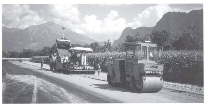
Einbau mit Strassenfertiger und anschliessende Verdichtung mit Vibrationswalze.
