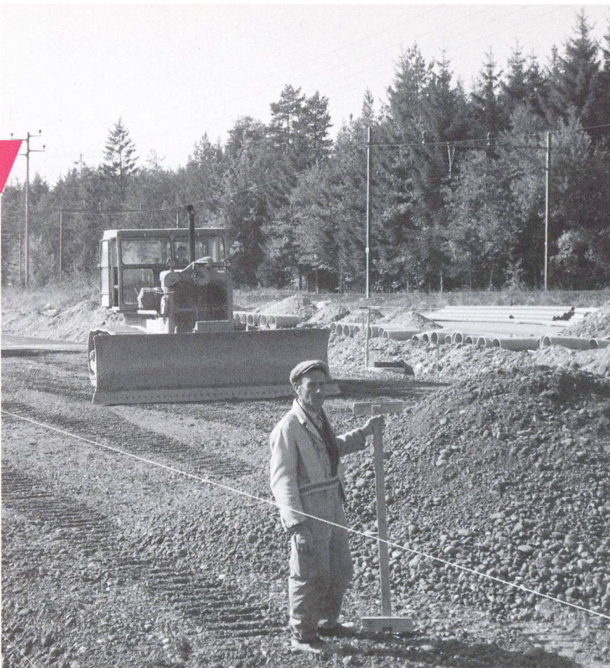
Planieren mit Dozer.
