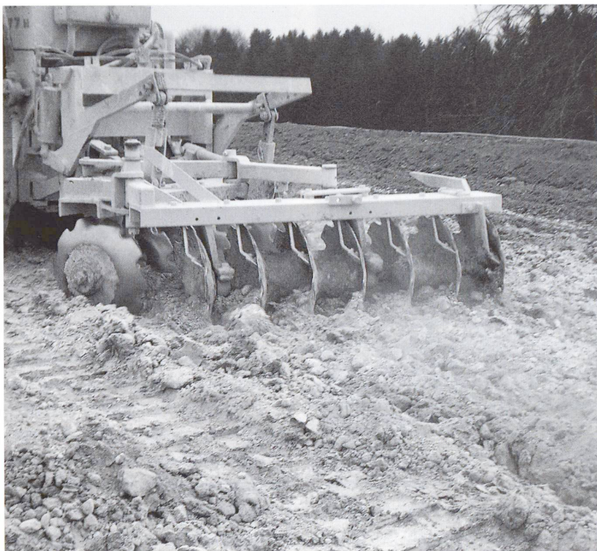
Einmischen des Zements mit einer Scheibenegge.
