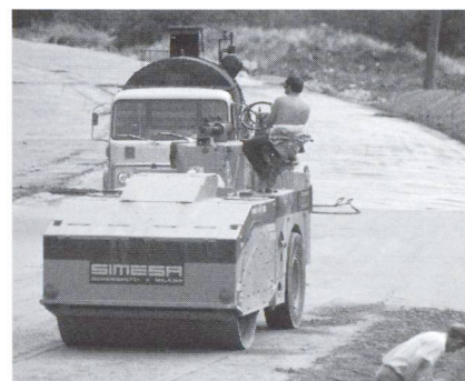
Verdichten mit Vibrationswalze.
