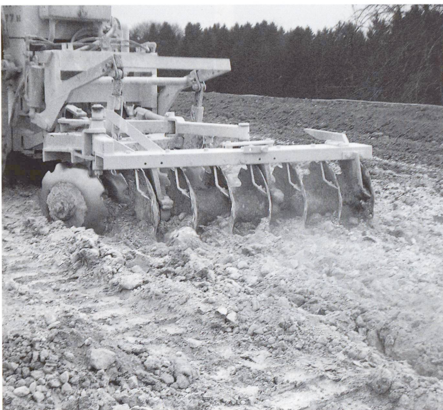
Einmischen des Zements mit einer Scheibenegge.
