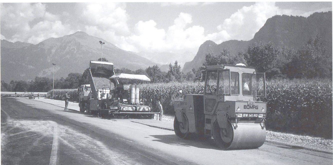
Einbau mit Strassenfertiger und anschliessende Verdichtung mit Vibrationswalze.
