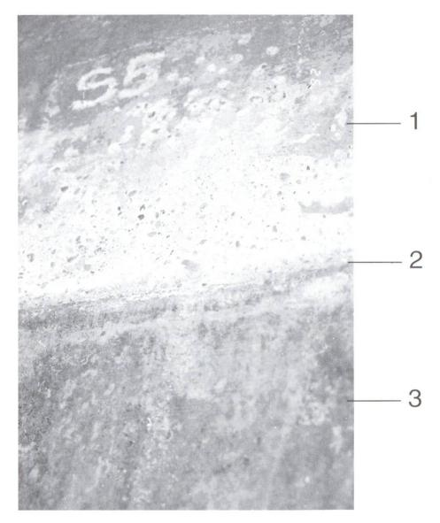
Biogene Schwefelsäurekorrosion in der Gaszone eines Nachklärbeckens (1: Gaszone, 2: Übergangszone, 3: Wasserzone mit intaktem Konstruktionsbeton).
