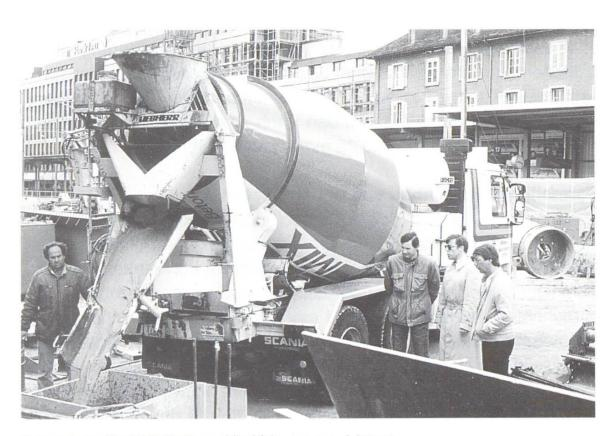
Schaumbeton lässt sich direkt vom Mischfahrzeug aus einbauen.
