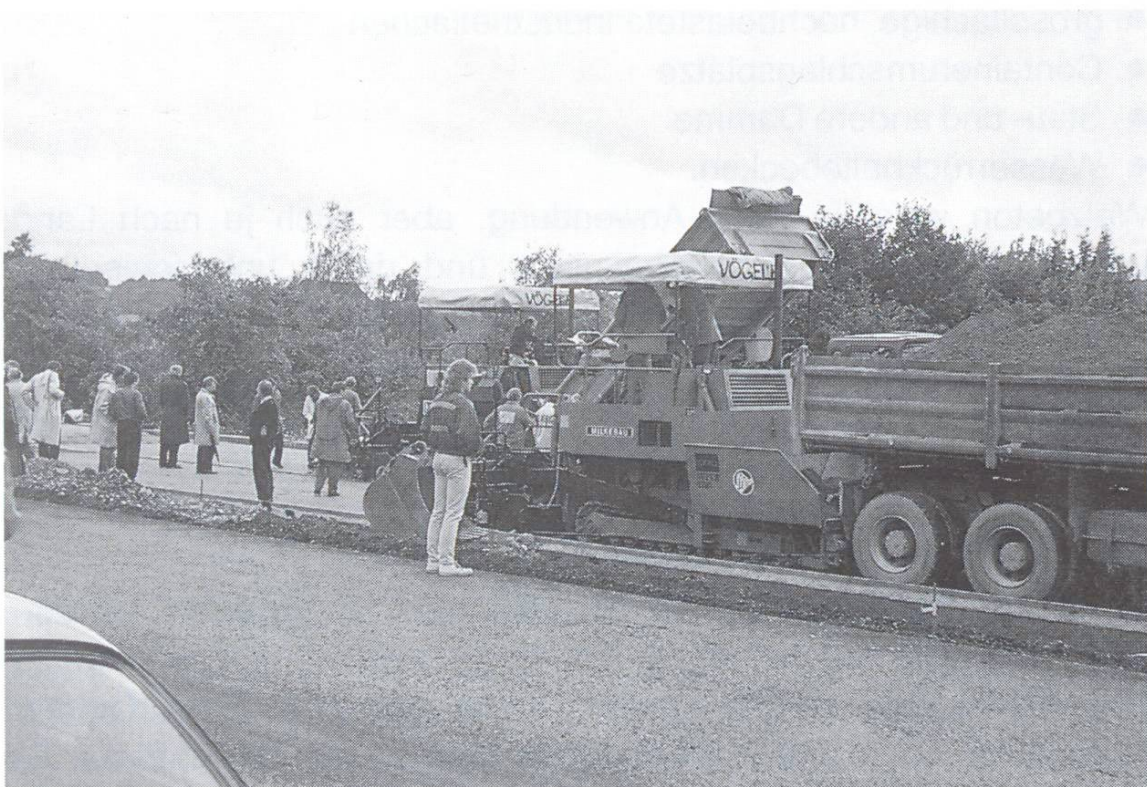
Kipper und Strassenfertiger, zwei wichtige Glieder der Einbaukette bei Walzbeton.
