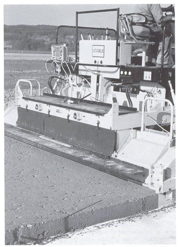
Einbau von Walzbeton mit Strassenfertiger.
