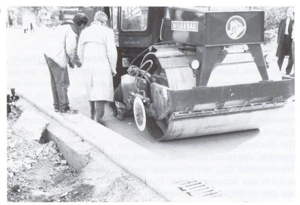
Verdichten von Walzbeton mit Vibrationswalze.
