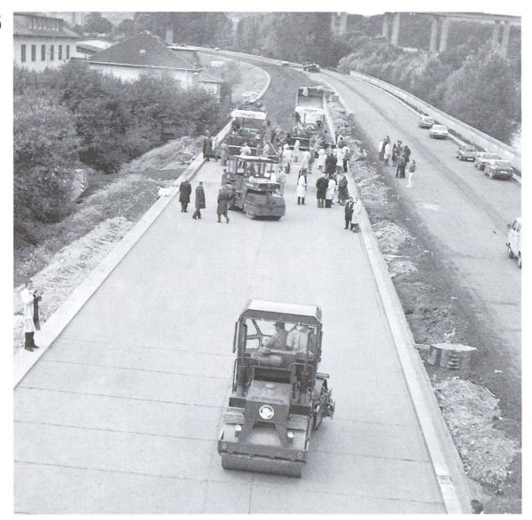
Zweispuriger Einbau von Walzbeton: Mit Kippern antransportierte Walzbetonmischung wird an die Strassenfertiger übergeben, von diesen eingebaut und schliesslich mit Vibrationswalzen verdichtet (von hinten).
