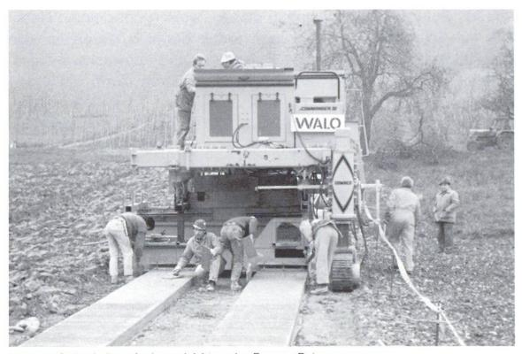
Moderne Gleitschalungsfertiger erleichtern den Bau von Betonspurwegen.
