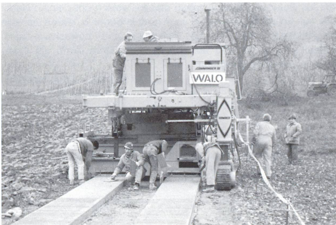
Moderne Gleitschalungsfertiger erleichtern den Bau von Betonspurwegen.
