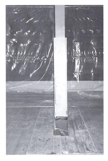
Beispiel für eine aufwendige Abdeckung zum Schutz vor Wasser: Verschweisste PVC-Folien an Wänden und Boden, in der Horizontalen durch Schaltafeln vor Verletzungen geschützt.
