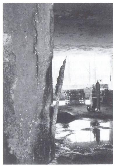
Abb. 4. Abplatzungen an einer brandgeschädigten Stütze.
