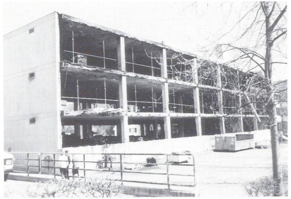
Abb. 1. Nach dem Brand in einem kunststoffverarbeitenden Betrieb: Die hochbeanspruchte Tragkonstruktion aus Stahlbeton hat sich bewährt.
