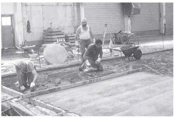
Leicht beanspruchte Industrieböden sind ein bedeutender Anwendungsbereich von kunststoffaserverstärktem Beton.
