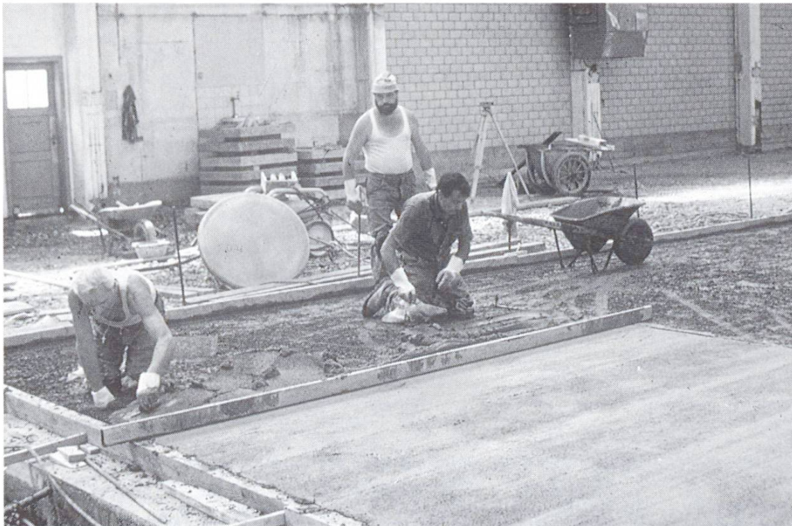
Leicht beanspruchte Industrieböden sind ein bedeutender Anwendungsbereich von kunststofffaserverstärktem Beton.
