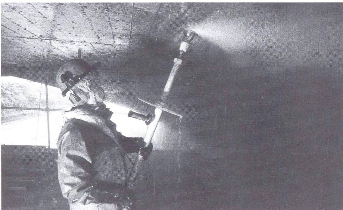
Abb. 2 Reinigung einer Brückenunterseite mittels einer Handlanze (1000 bar). Man beachte die umfangreichen Massnahmen zum Schutz des Arbeiters.
