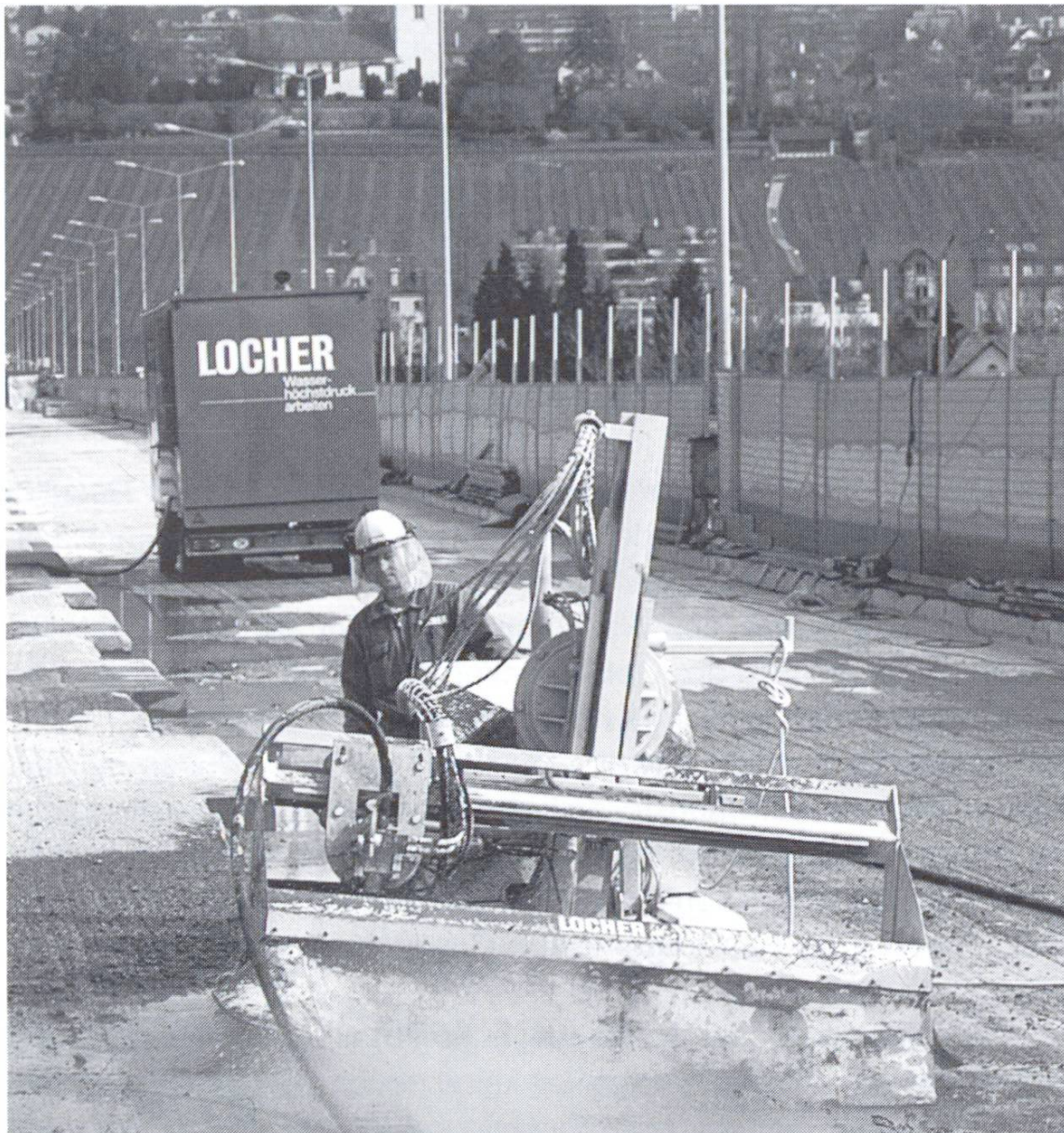
Abb. 4 Horizontaler Abtrag von Beton mit robotergesteuertem Höchstdruckwasserstrahlgerät (Druck 1000 bar, Volumenstrom 138 l/min). (Fotos: Locher & Cie AG, Zürich)
