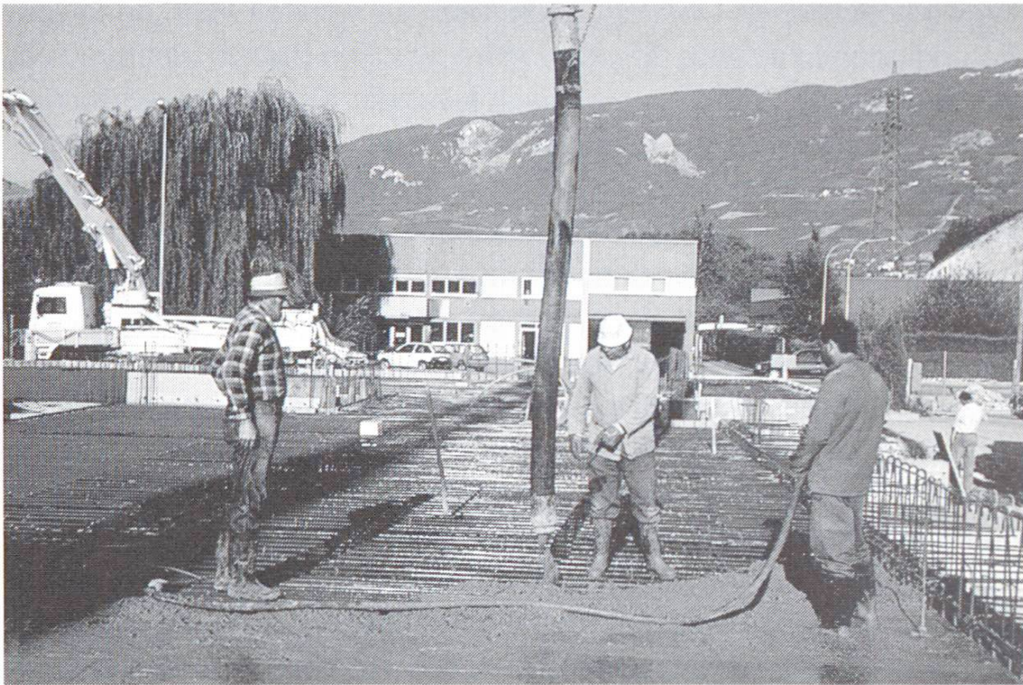
Betonieren der Bodenplatte einer Käserei. Der Beton wird bei beschichteten Bewehrungen wie bei normaler Bewehrung eingebracht. (Foto: Von Roll)
