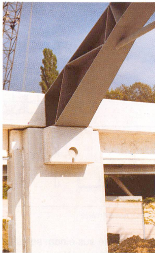
Abb. 7 Auflager für Stahlträger der Dachkonstruktion
