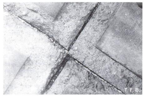
Abb. 7 Die häufig anzutreffenden Fugeneinlagen aus 10 mm Schaumstoff und mehr sind hier ungeeignet. Zudem waren die Fugen nicht geradlinig durchgeführt. Im Bereich der Kanten platzte der Hartbeton ab und musste erneuert werden. Also: sauber abschalen, Fugenstreifen von weniger als 6 mm Dicke verwenden.
