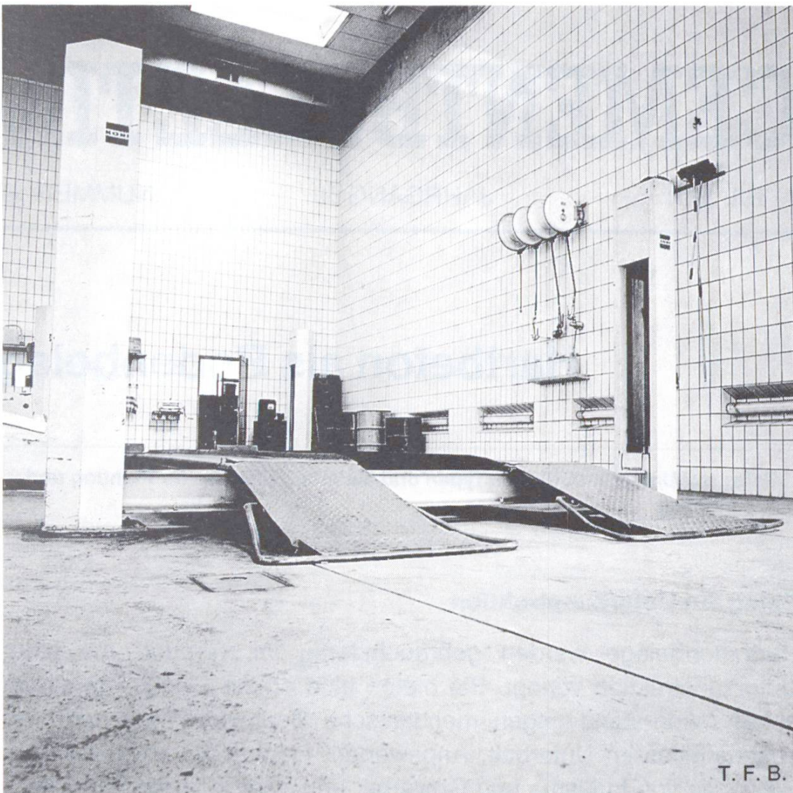
Abb. 1 Fertig verlegter Hartbetonbelag für Werkstätte, bereits in Gebrauch.
