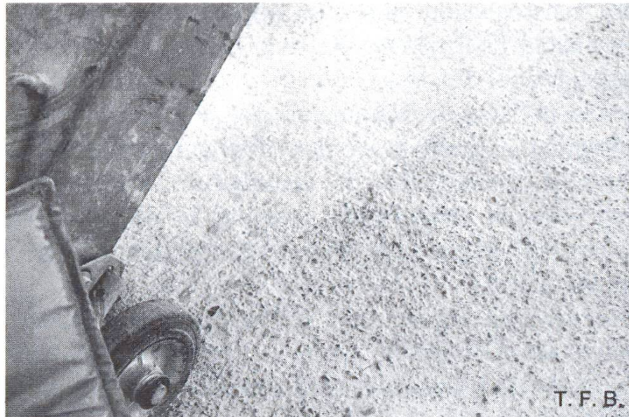
Abb. 5 Beispiel eines guten Untergrunds. Einmaliges Überfräsen genügt.
