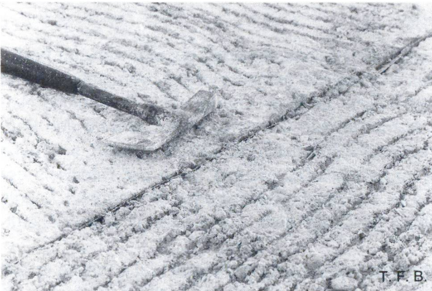
Abb. 8 Sauber vorbereiteter Untergrund. Die Arbeitsfuge ist mit Dachpappe getrennt und kann mit Hartbeton überzogen werden. Allenfalls entsteht ein bedeutungsloser Haarriss.
