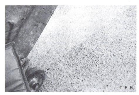
Abb. 5 Beispiel eines guten Untergrunds. Einmaliges Überfräsen genügt.
