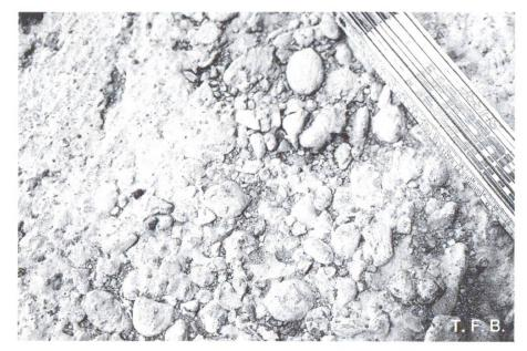
Abb. 4 Beispiel eines schlechten Untergrunds. Die losen Teile müssen erst noch entfernt werden.
