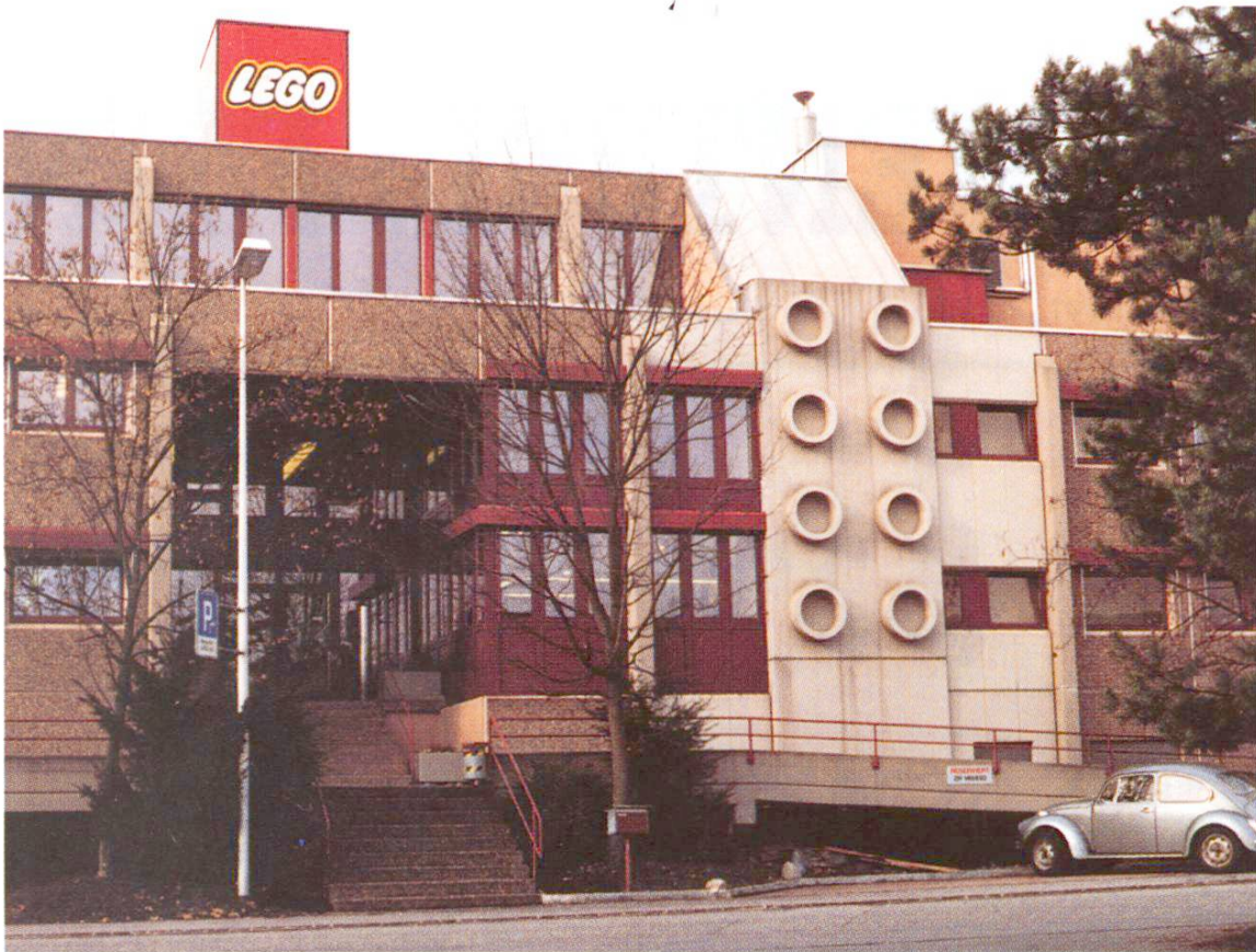
Abb. 1 Das Firmenzeichen ist nicht in Beton ausgeführt. Hingegen wurde ein bekanntes Firmenprodukt stilisiert und als Konstruktionselement verwendet. Lego, Baar
