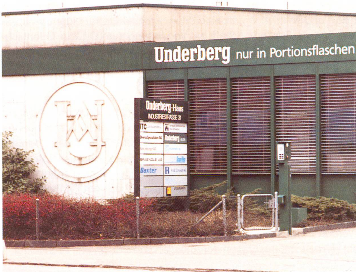
Abb. 2 Firmenzeichen als Wandrelief. Underberg, Dietlikon
