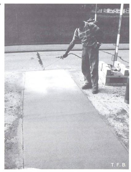
Abb. 5 Reparatur eines Betonbelags. Aufbringen von Curing Compound als Nachbehandlung. Beginn etwa 5–15 Minuten nach der Oberflächenbehandlung (d. h. sobald die Oberfläche matt ist). Anschliessend Abb. 6
