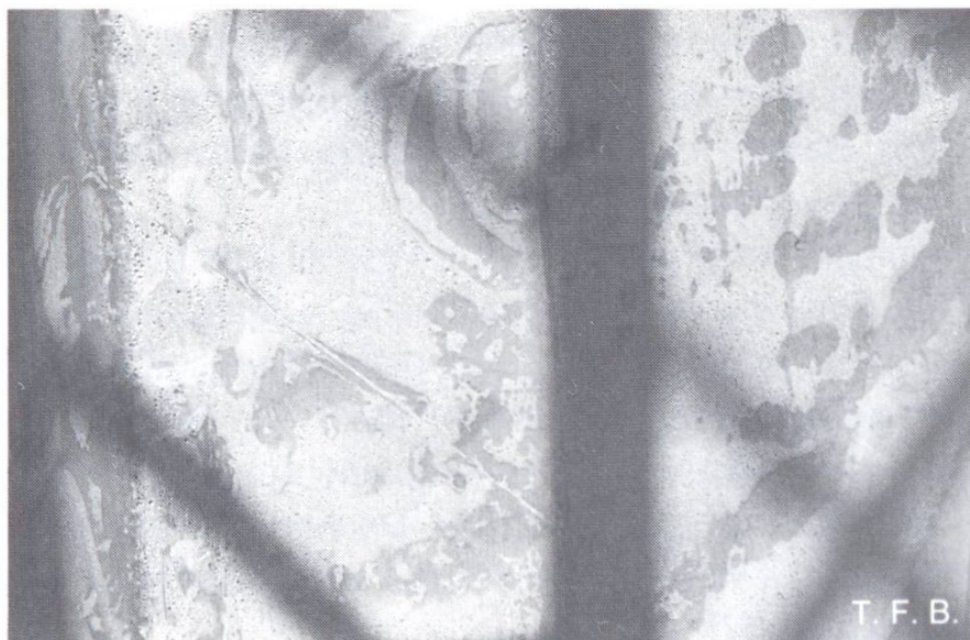
Abb. 3 Nahaufnahme: Die austretende Feuchtigkeit kann nicht entweichen, sie kondensiert am Plastik. Dadurch bleibt die Oberfläche in einem günstigen Klima
