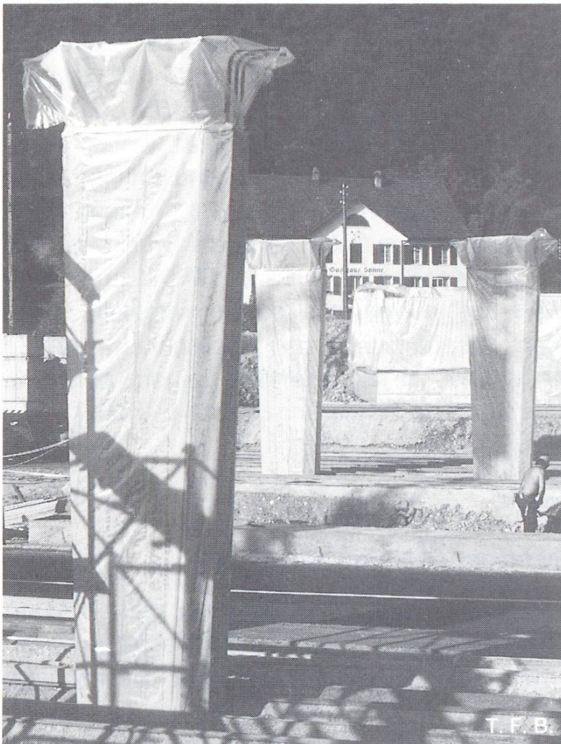
Abb. 2 Pfeiler und Widerlager einer Strassenüberführung. Der Beton ist mit Plastik eingepackt. Zweck: Nachbehandlung des Betons und Schutz der Sichtfläche vor Rostfahnen der Anschlussbewehrung oder vor Kalkschnäuzen infolge Regenwassers (Kanton Aargau: Brücke K 364, Juli 1988)
