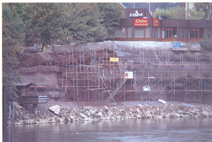
Abb. 10 Gerüstung für die Spritzbetonarbeiten
