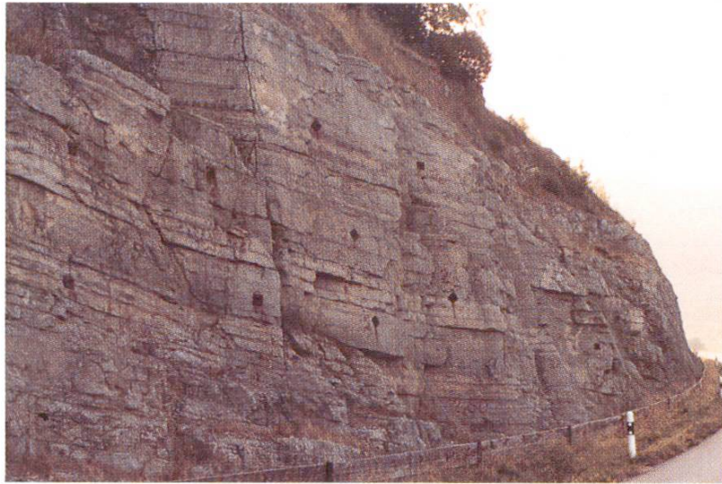
Abb. 15 Südlicher Teil vor der Sanierung
