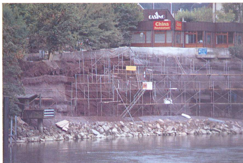
Abb. 10 Gerüstung für die Spritzbetonarbeiten
