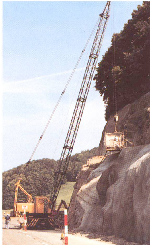
Abb. 14 Spritzbetonarbeiten ab Hängebühne
