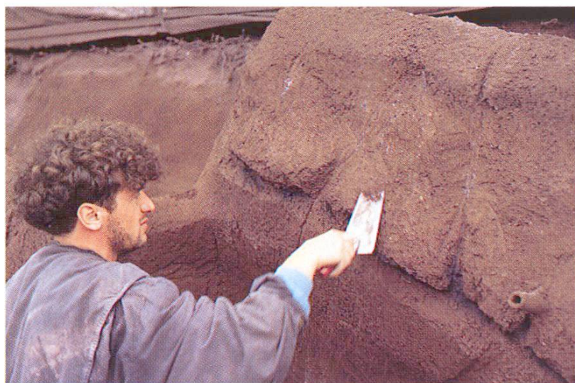
Abb. 11 Strukturierung (Handarbeit)
