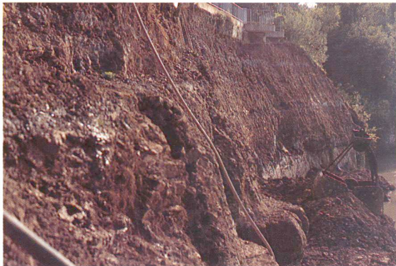
Abb. 9 Abtrag (wechselnde Hangneigung!)
