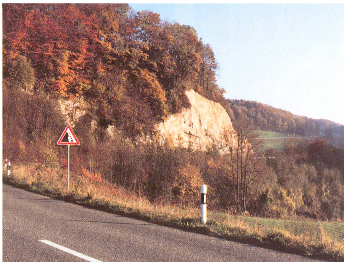
Abb. 18 Die Sicherungsarbeiten mittels Spritzbeton und Netzen wurden auf das Notwendigste innerhalb der Felswand beschränkt, womit jedoch die Steinschlaggefahr weitgehend beseitigt werden konnte
