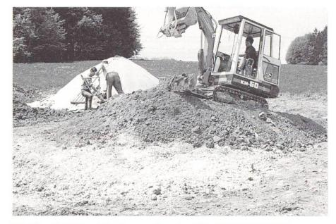
Abb. 11 Mischen mit Kleinbagger. Depot, mit Plastikfolie abgedeckt
