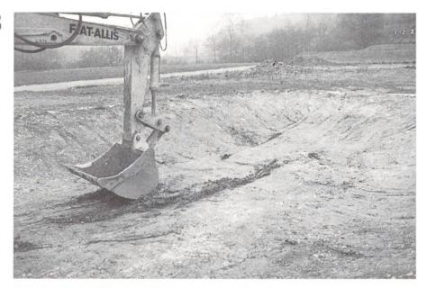
Abb. 8 Aushub für einen Weiher, mit normalem Aushubgerät
