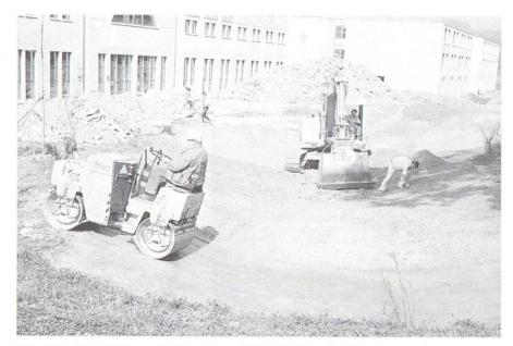
Abb. 14 Verdichten mit Vibrationsglattwalze (flache Böschungen)
