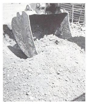
Abb. 3 Mit Kalk stabilisiertes Bodenmaterial (verarbeitbar, krümelig)
