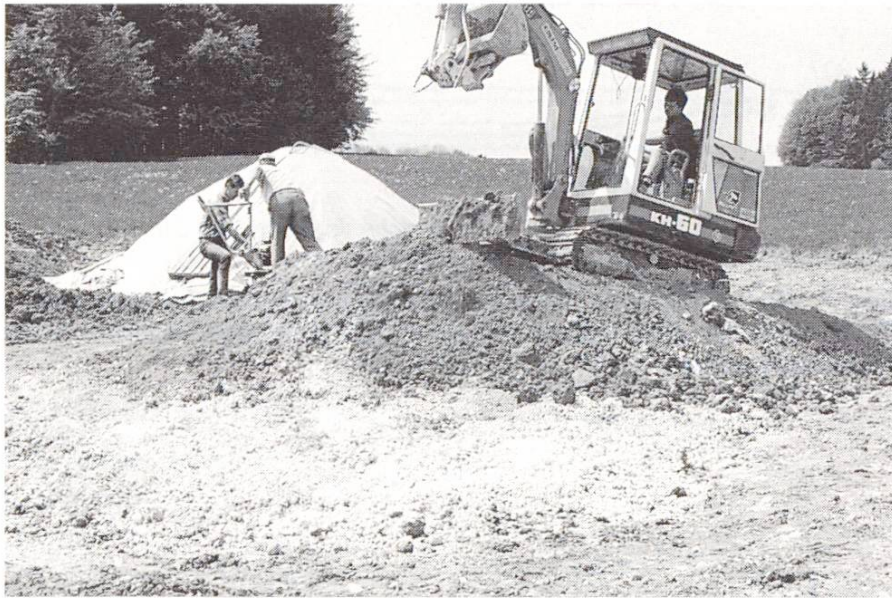
Abb. 11 Mischen mit Kleinbagger. Depot, mit Plastikfolie abgedeckt
