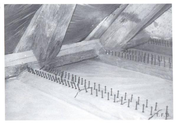
Abb. 3 Aufbau mit Spezialschraube (Stadler Verbundelement VB-48-6,5×100 mm). Arbeit im Dachstock. In diesem Gebäude konnte mit Normalbeton gearbeitet werden. Die Schrauben folgen der Balkenoberschicht und den beschränkten Platzverhältnissen beim Eindrehen
