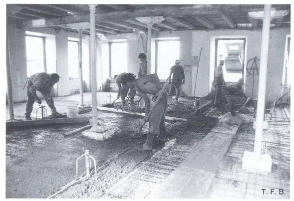
Abb. 9 Betonförderung mit Krankübel ab Umschlaggerät durch Seitenfenster. Transport mit Karrette und Einbringen
