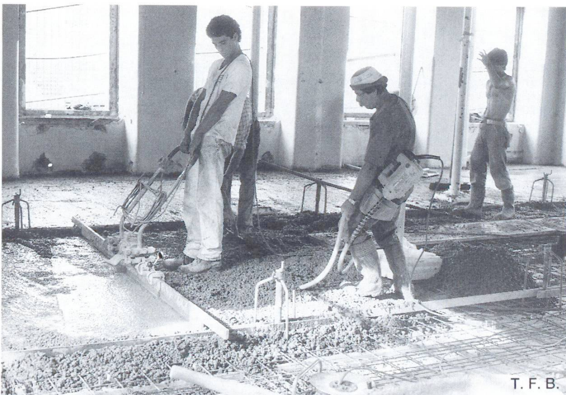
Abb. 10 Vorvibrieren mit Vibrator \varnothing 30 mm, Vibrieren mit Vibrierlatte
