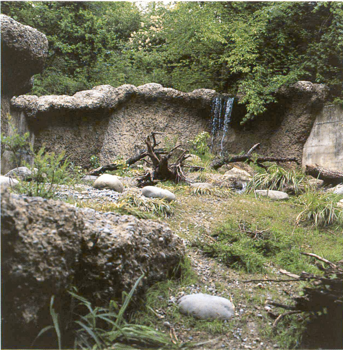
Abb. 2 Abschlussmauer mit Überhang, um ein Überklettern zu verhindern (Fischotteranlage)
