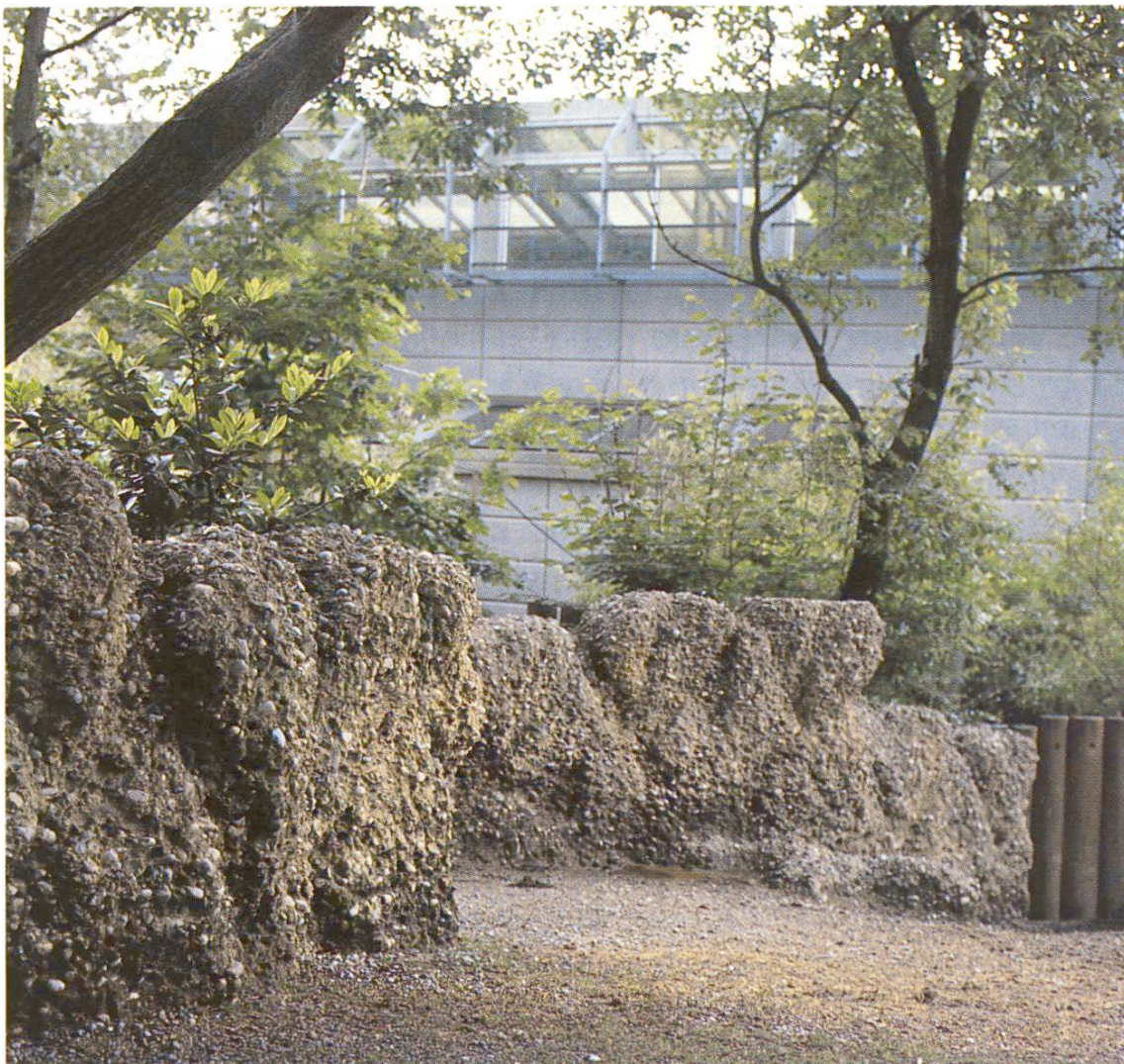
Abb. 1 Nagelfluhbeton als Abschlussmauer im Tiergehege einer Freianlage
