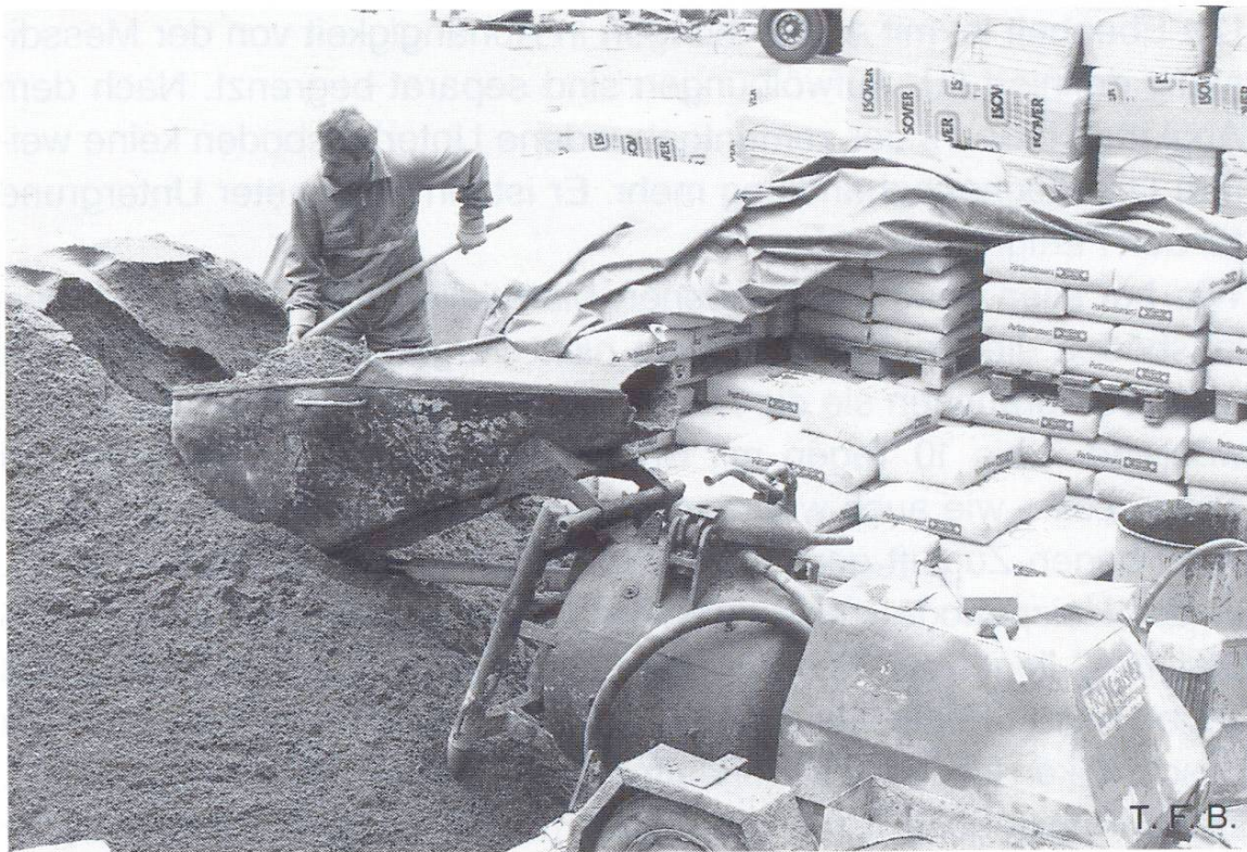
Abb. 2 Mischen des Mörtels und Pumpen zur Einbaustelle
