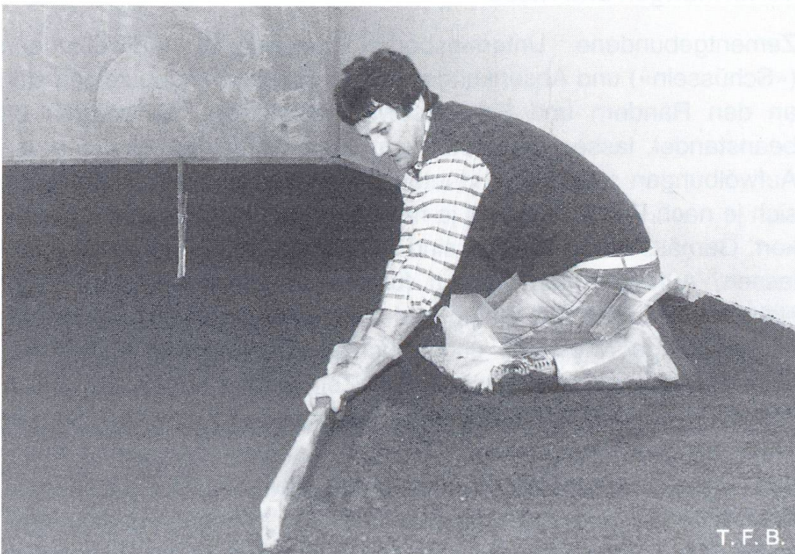
Abb. 3 Abziehen des Mörtels auf Sollhöhe
