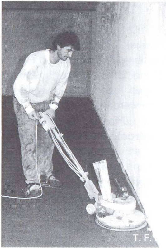
Abb. 4 Abtallochieren mit der Glättmaschine. In der Regel wird die Scheibe verwendet.
