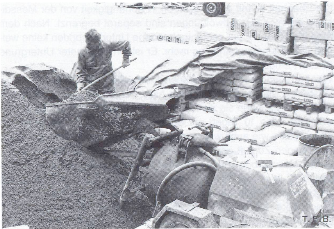
Abb. 2 Mischen des Mörtels und Pumpen zur Einbaustelle
