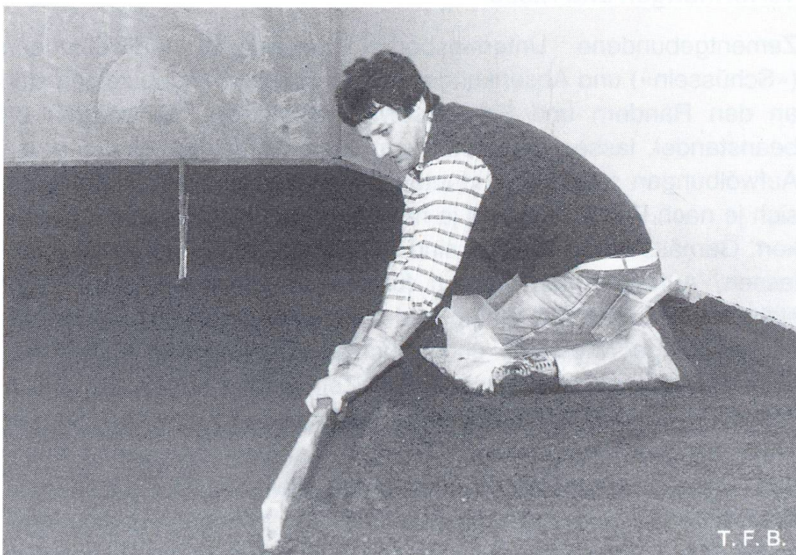
Abb. 3 Abziehen des Mörtels auf Sollhöhe
