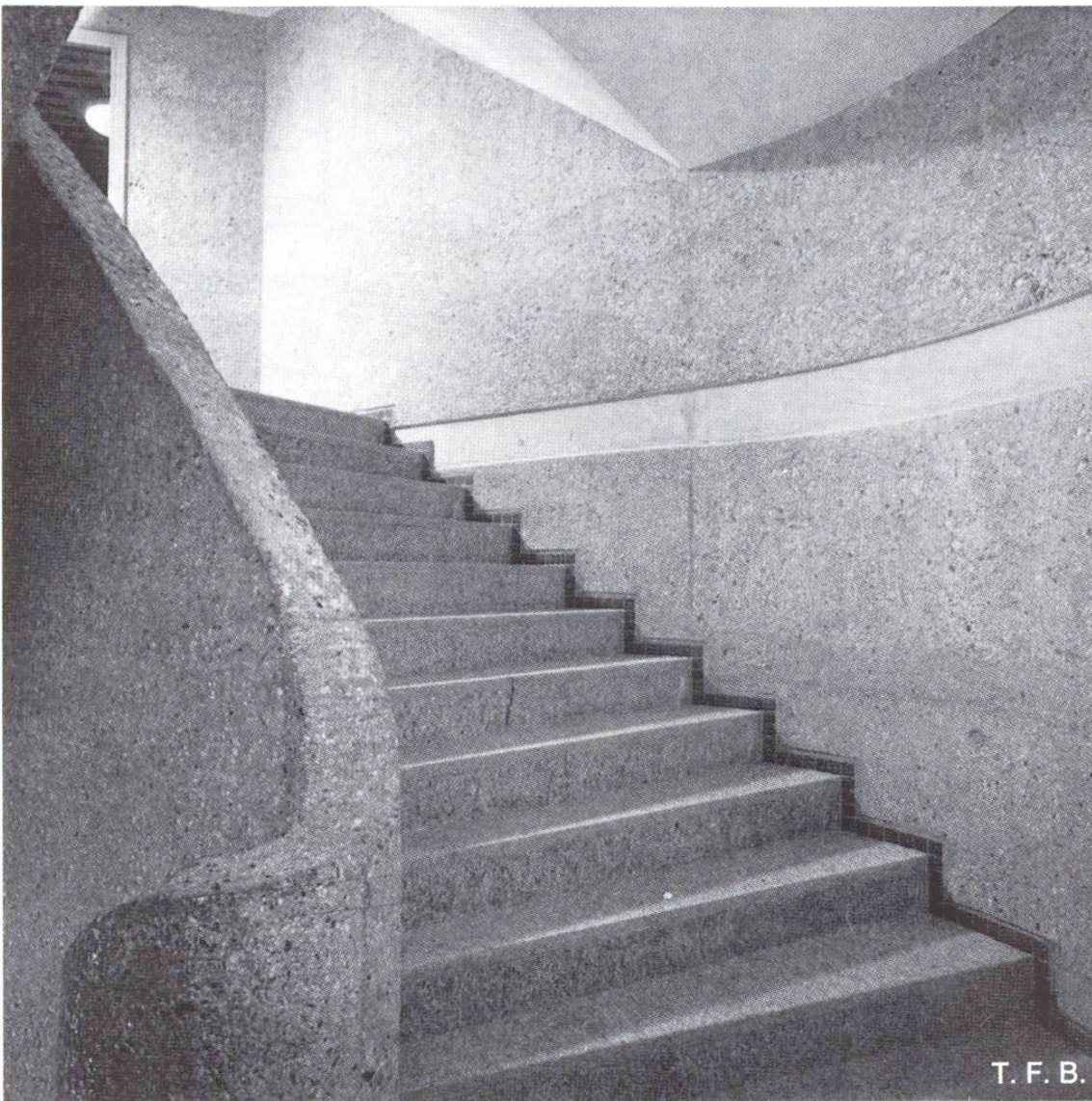
Abb. 7 Sichtbeton im Treppenhaus
