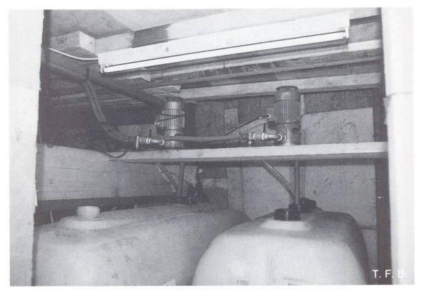
Abb. 3 Blick in den behelfsmässigen Raum für die Zusatzmittel. Sichtbar sind die Tanks mit Förderpumpen und Steigleitungen. Beleuchtung für Betrieb und Revisionsarbeiten. Raum dauernd beheizt.
