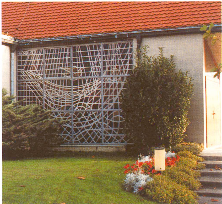
Abb. 3 Aussenansicht des Fensters auf der Westseite.
