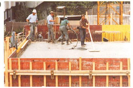
Abb. 12 Beendigung der Betonierarbeit an der Decke.
