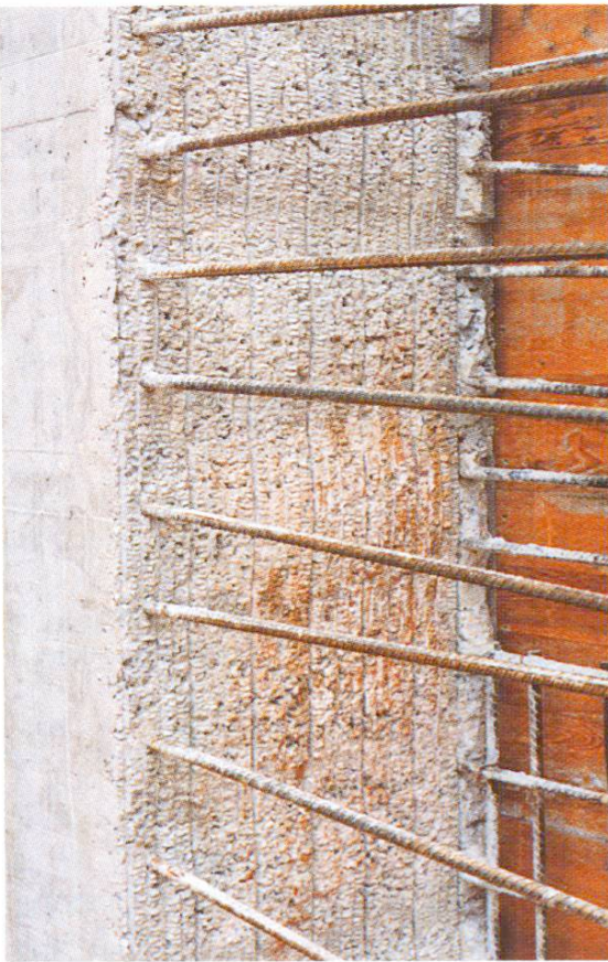
Abb. 3 Arbeitsfuge. Streckmetall wieder entfernt, gereinigt.
