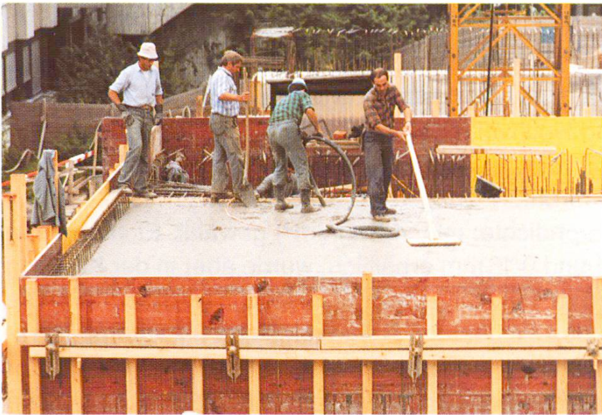
Abb. 12 Beendigung der Betonierarbeit an der Decke.
