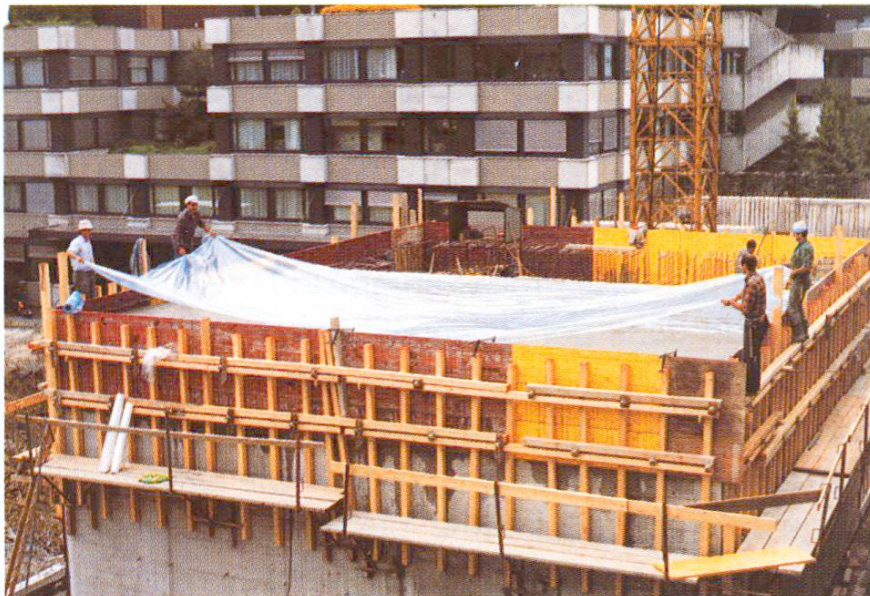
Abb. 13 Abdecken mit Bauplastik.
