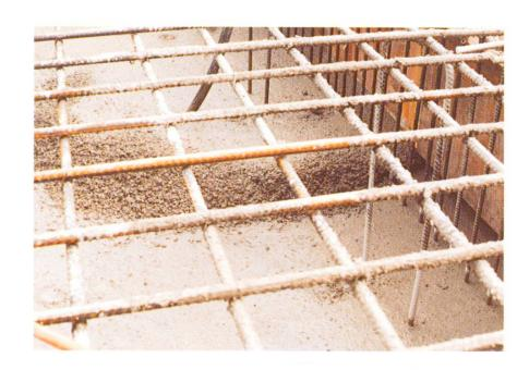
Abb. 10 Schichtweises Einbringen in Höhen von etwa 25 cm.
