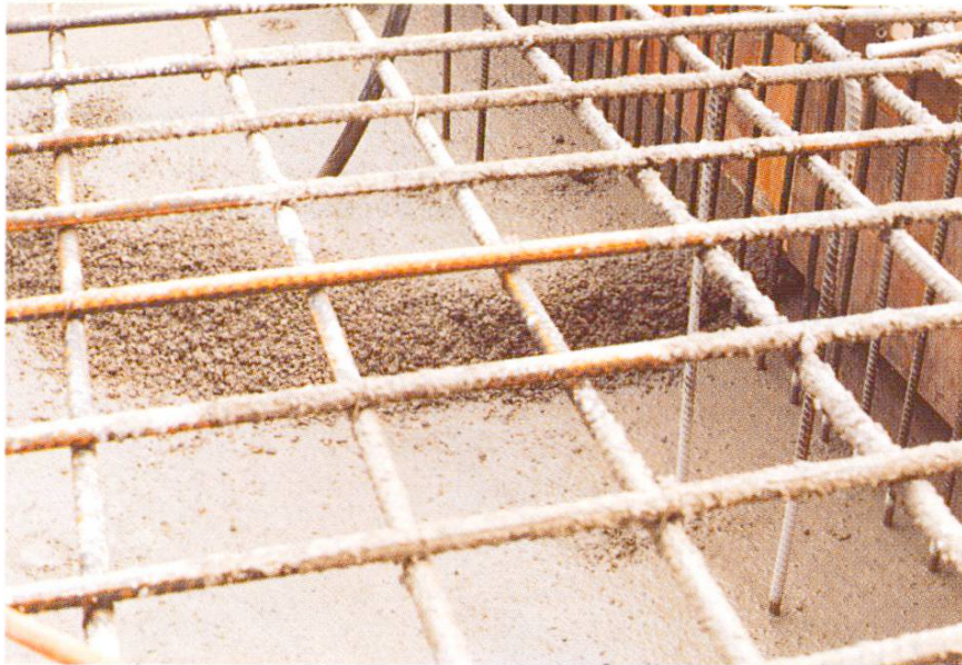
Abb. 10 Schichtweises Einbringen in Höhen von etwa 25 cm.
