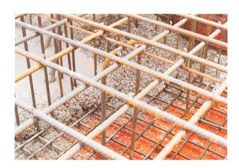
Abb. 11 Fortsetzung bei Deckenabsatz.
