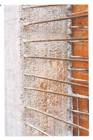
Abb. 3 Arbeitsfuge. Streckmetall wieder entfernt, gereinigt.
