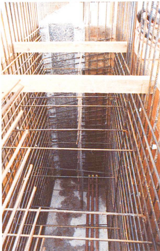
Abb. 5 Wandetappe, zum Betonieren vorbereitet. Gereinigt und angefeuchtet.
