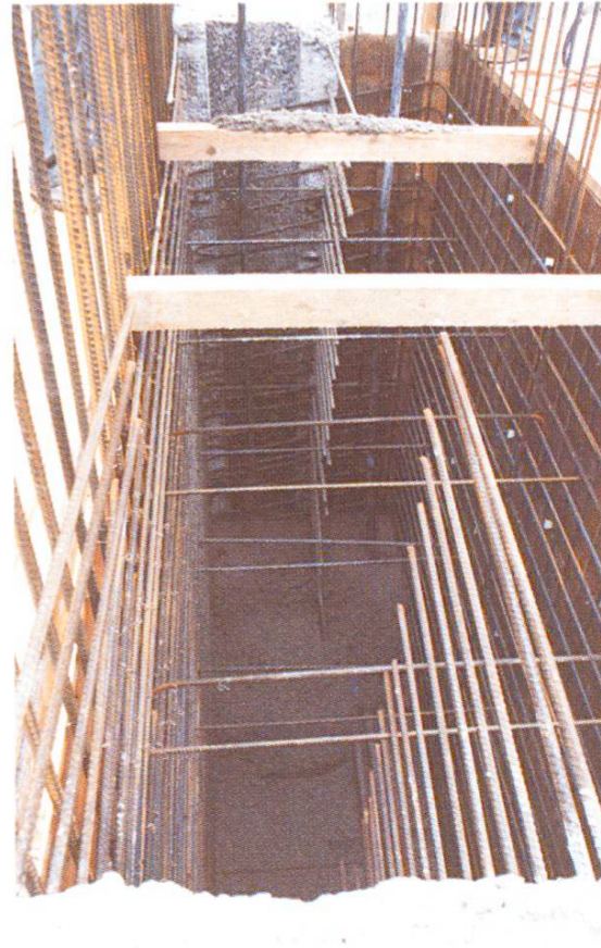
Abb. 6 Beginn der Betonarbeit. Sichtbar sind die kräftigen Distanzhalter der Bewehrung.
