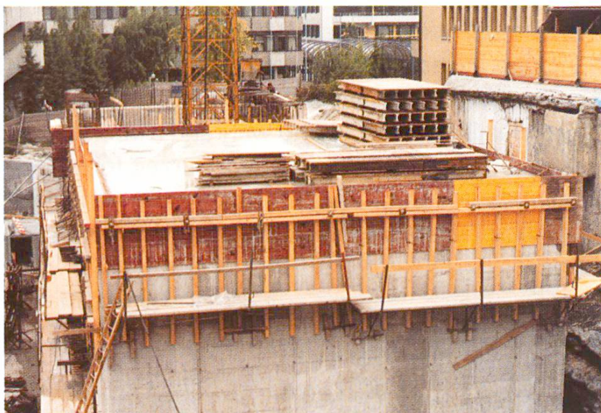
Abb. 14 Feuchthalten durch fortwährendes Wässern während 7 Tagen.
