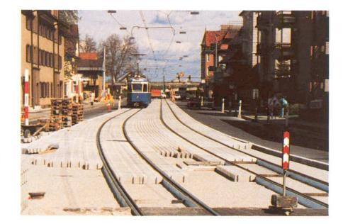
Abb. 8 Trassee für Strassenbahn, nach Beendigung der Bauarbeiten begrünt. Starke Dämpfung des Lärms.
