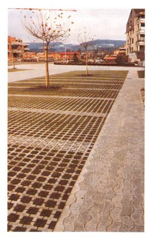
Abb. 3 Markierung der Parkflächen mit Füllsteinen.
