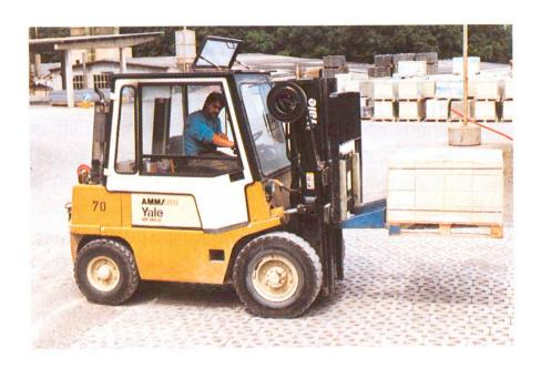
Abb. 10 Spezieller Gitterstein für Lagerplatz.
