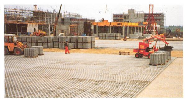
Abb. 4 Verlegen der Rasengittersteine: bei grösseren Flächen maschinell.
