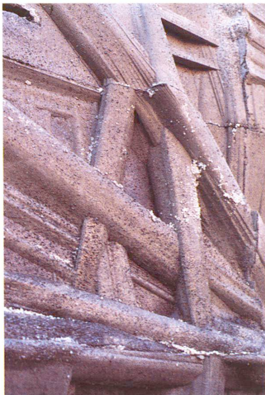
Detail nach dem Ausschalen, noch ungereinigt.
