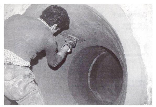
Abb. 7 Aufbringen einer Zementmörtelauskleidung.
