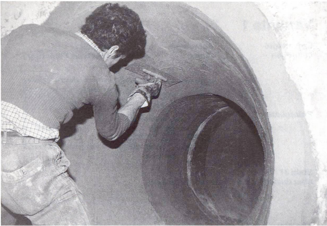
Abb. 7 Aufbringen einer Zementmörtelauskleidung.
