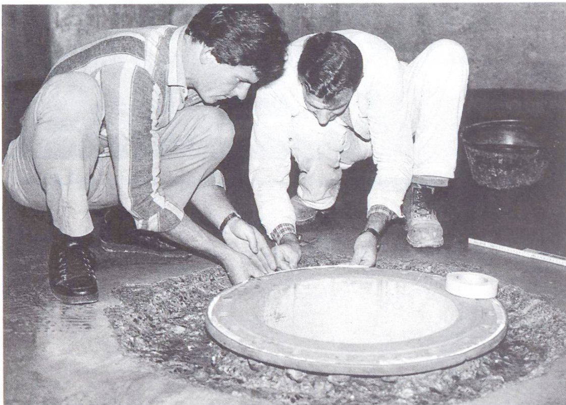
Abb. 6 Sanierung eines Flansches (vgl. Abb. 4) mittels Zementpassivierung.
