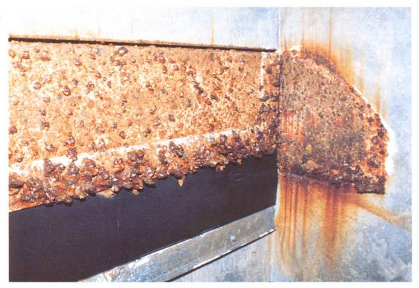
Abb. 5 Korrosionsschaden an Stauklappe eines Aktivkohlefilters nach fünf Jahren Betrieb. Verstärkte Korrosion durch Luft-Wasser-Verhältnisse mit Ozon (gleiche Ausführung wie Abb. 3).
