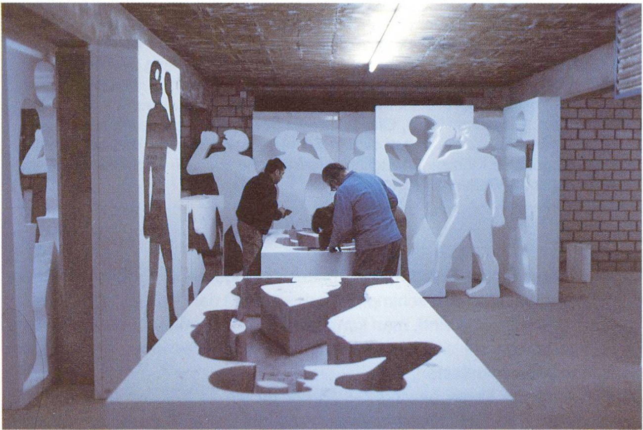
Schalung aus Schaumstoff. Arbeit am Negativ
