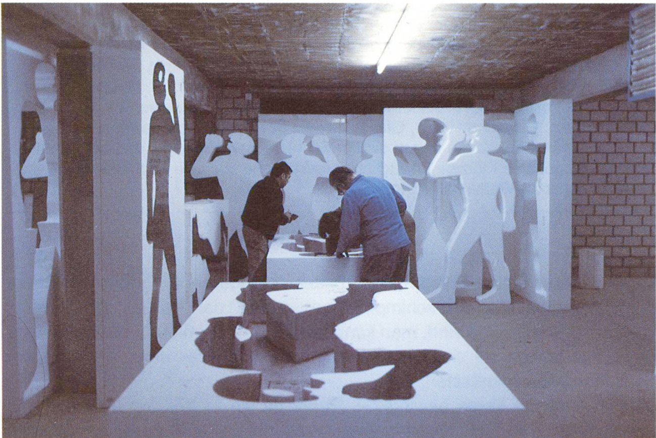
Schalung aus Schaumstoff. Arbeit am Negativ
