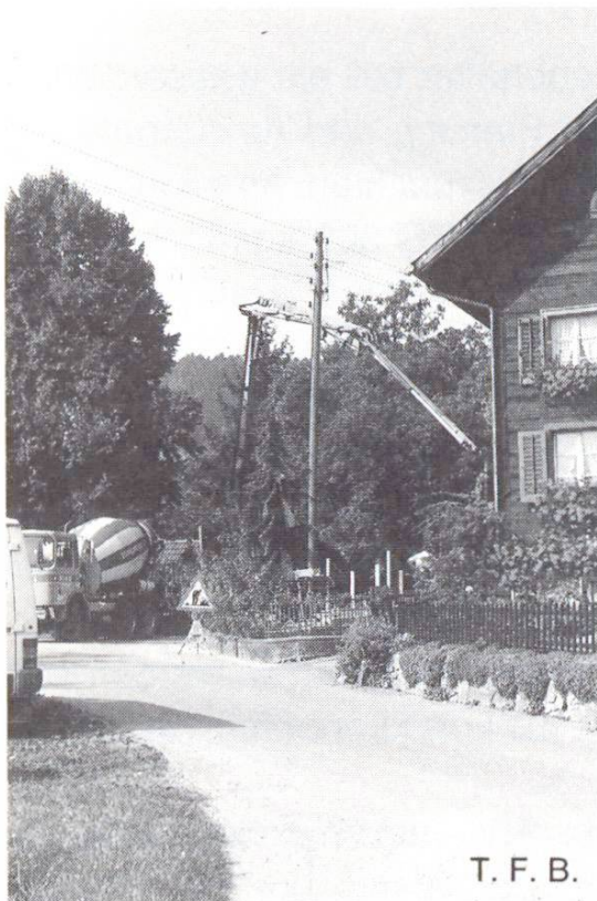
Abb. 12 Zufahrtsmöglichkeit und Werkleitungen berücksichtigen.
