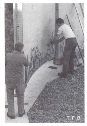
Abb. 10 Güllebehälter in Betonelementen. Montage auf zuvor erstellten Montagestreifen. Kieskoffer als Unterlage für die Bodenplatte.
