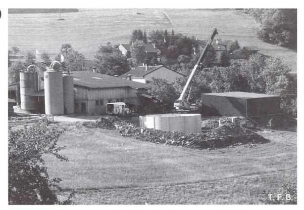
Abb. 14 Güllebehälter nach Montage der Elemente. Hinterfüllen mit Aushub und Gestalten der Böschung zur Abrundung der Hofanlage. Anbringen eines Schutzzaunes, sofern Behälterwand nicht mehr als 1 m über Terrain führt (Buckten, Kanton Baselland).
