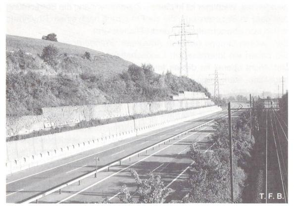
Abb. 2 Die Form der Stützmauer soll nicht allein durch geometrische und statische Berechnung, sondern auch durch die optische Wirkung bestimmt werden (N4 bei Meierskappel).
