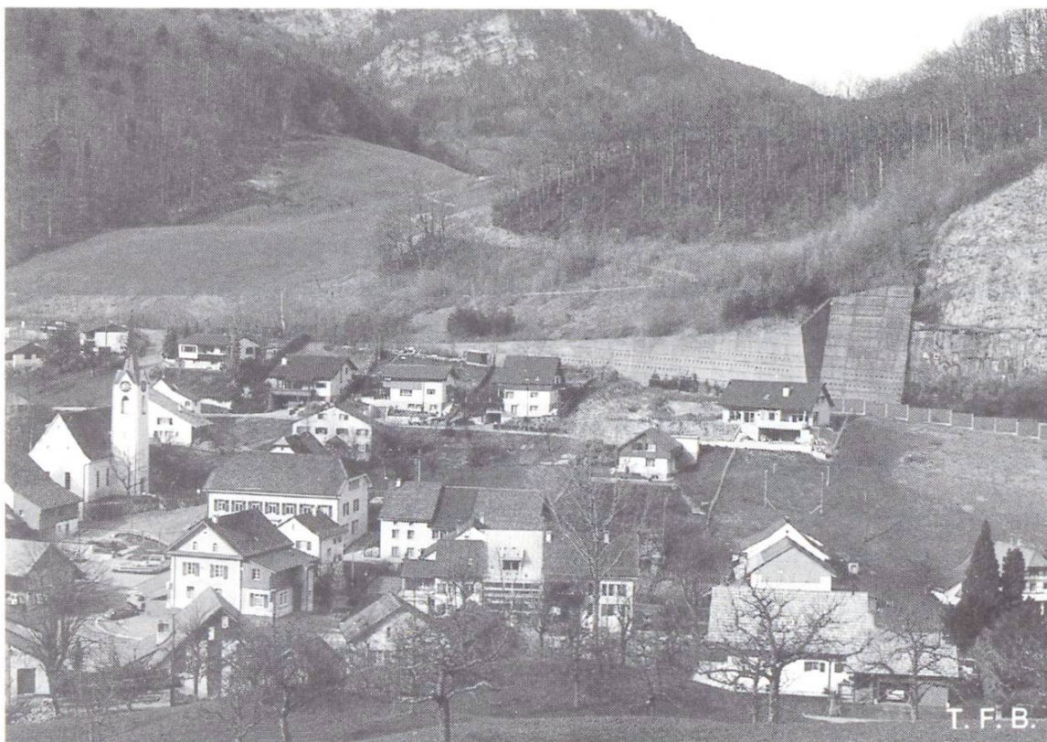
Abb. 6 Dieselbe Mauer wie in Abb. 5, vom Standort der Anwohner aus gesehen.
