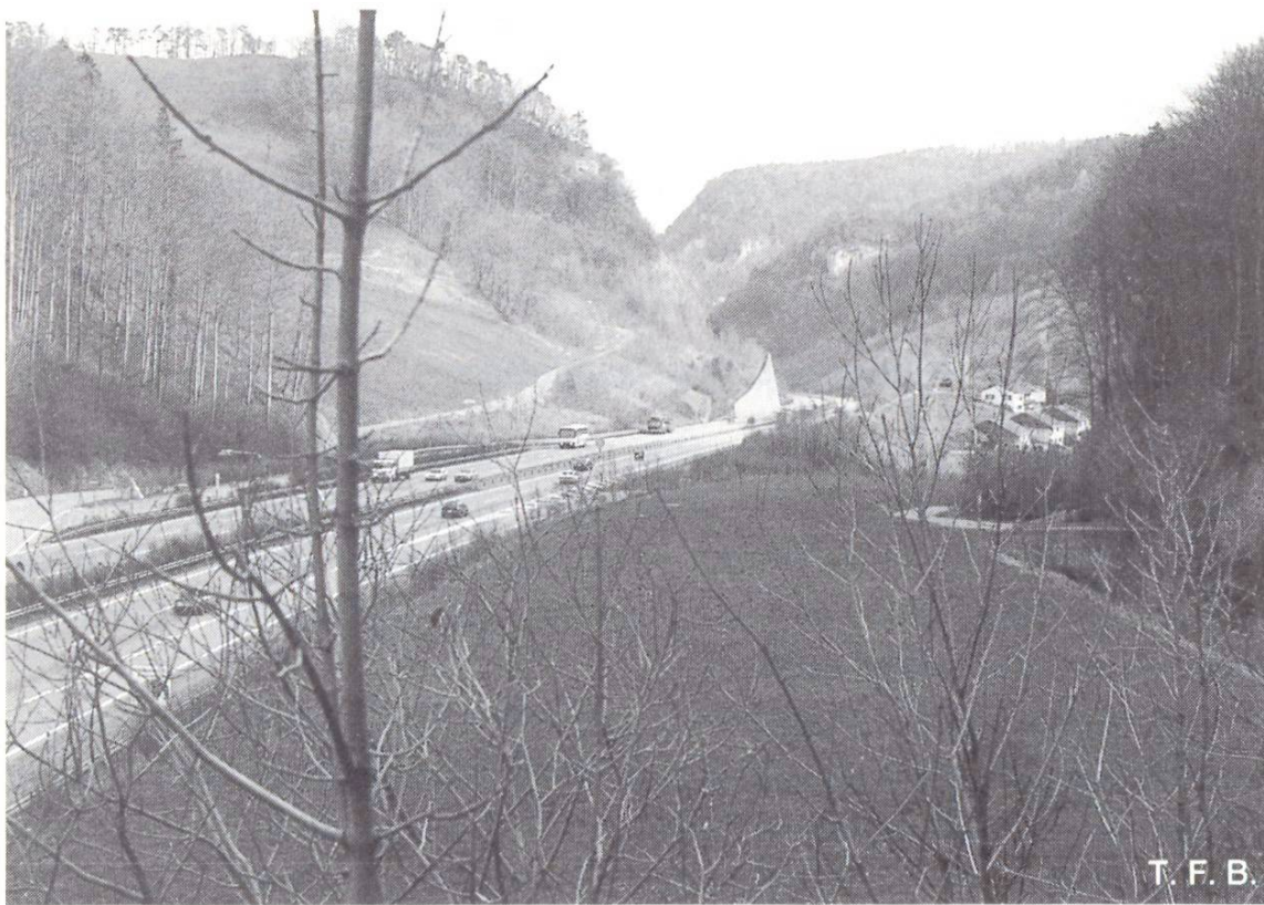
Abb. 5 Zur Beurteilung der optischen Wirkung sind Standpunkte von verschiedenen Betrachtern einzunehmen. In Bildmitte eine Stützmauer, wie sie ein Autofahrer sieht (N2 bei Eptingen).
