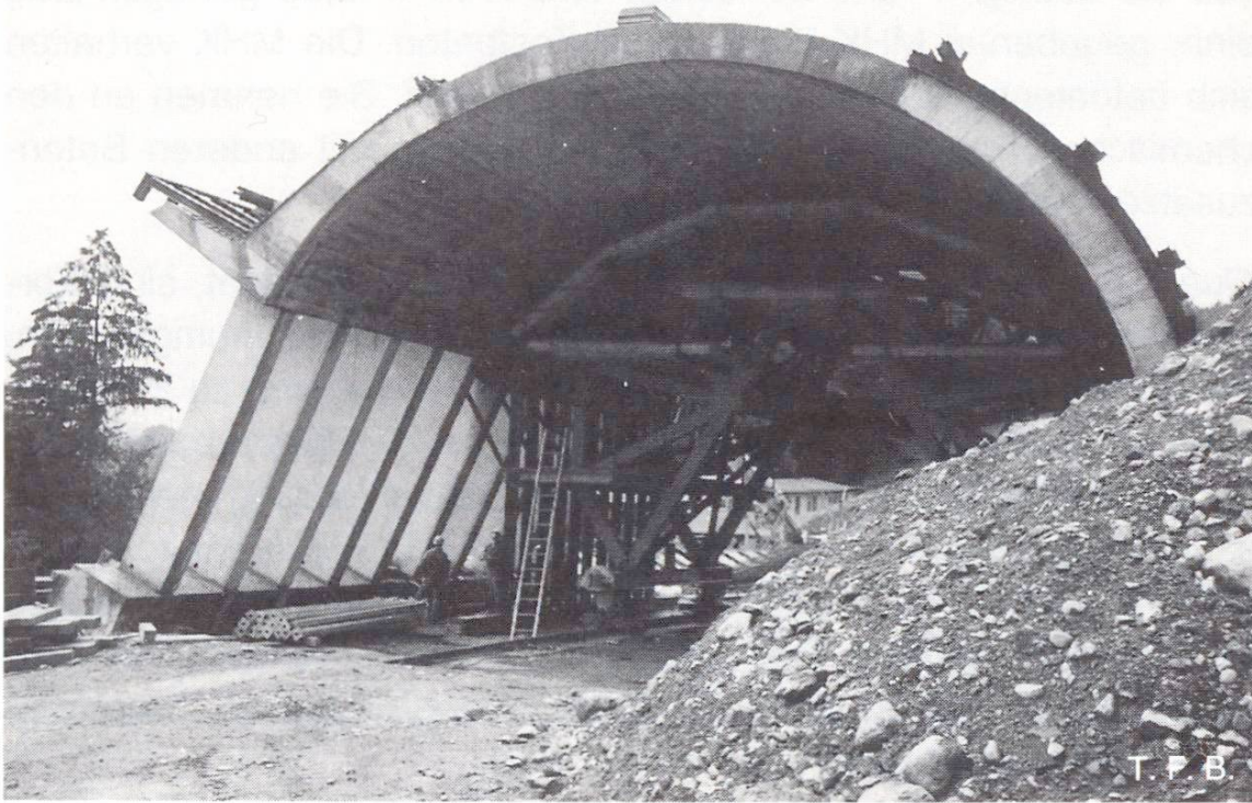
Abb. 5 Tunnel Spiezwiler (Arge Frutiger, Marti, Lanz). Tagbaustrecke Süd. Fundament: überdeckt, ohne Luftporenzusatz. Stützen: vorgefertigt, mit Luftporenmittel. Gewölbe: Ortbeton mit MHK als Zusatz. Vorgesehen ist zur Zeit, auch das Innengewölbe der Untertagstrecke als Luftporenbeton mit MHK herzustellen.
