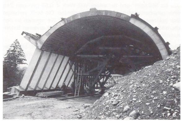
Abb. 5 Tunnel Spiezwiler (Arge Frutiger, Marti, Lanz). Tagbaustrecke Süd. Fundament: überdeckt, ohne Luftporenzusatz. Stützen: vorfabriziert, mit Luftporenmittel. Gewölbe: Ortbeton mit MHK als Zusatz. Vorgesehen ist zur Zeit, auch das Innengewölbe der Untertagstrecke als Luftporenbeton mit MHK herzustellen.
