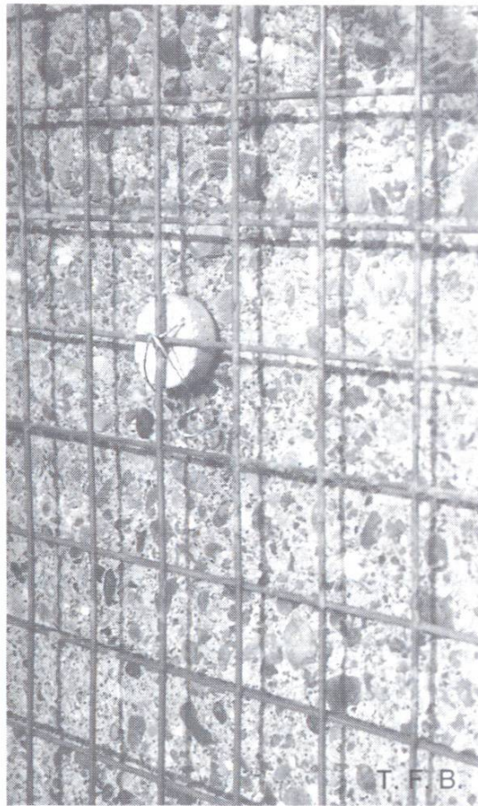
Abb. 7 Netzarmerung des Vorbetons, am bestehenden Beton gesichert.
