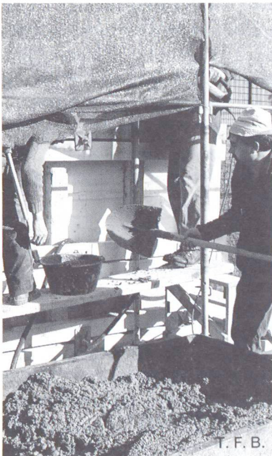
Abb. 8 Transportbeton aus der Mulde in den Kübel zur Schalung.
