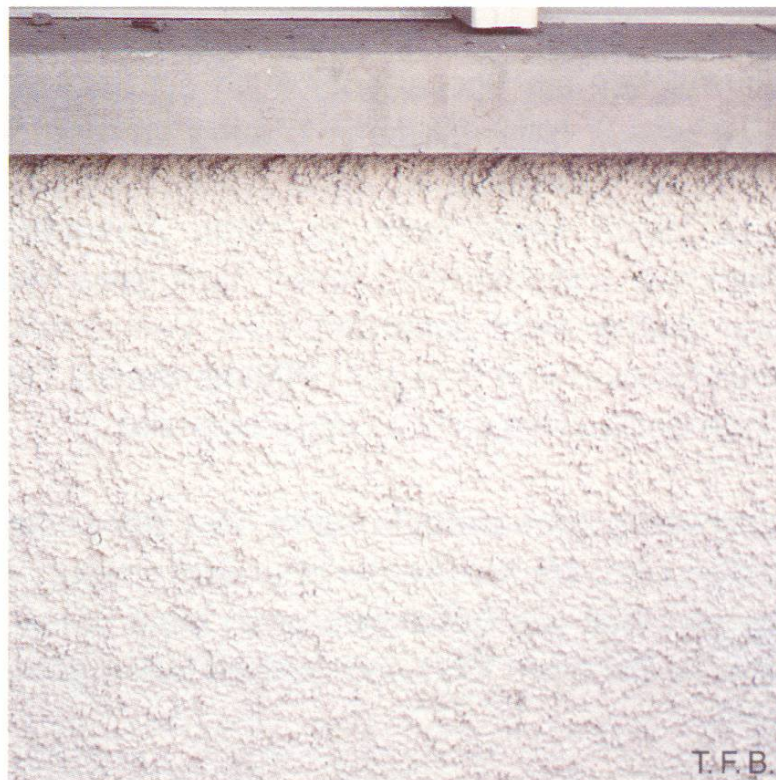
Abb. 14 Kellenwurf als Deckputz (Lindenplatz Pfungen).
