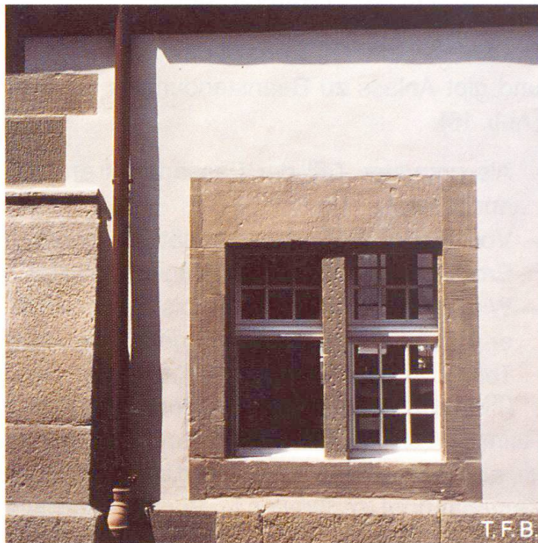
Abb. 13 Abrieb 1 mm, gestrichen (Schloss Laupen, 1985).
