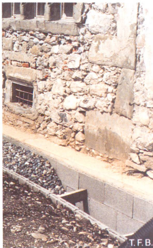
Abb. 21 Dieselbe Mauer nach Sicherung mit Fliessbeton (HK als Bindemittel). Sickerpackung gemäss Abb. 19.
