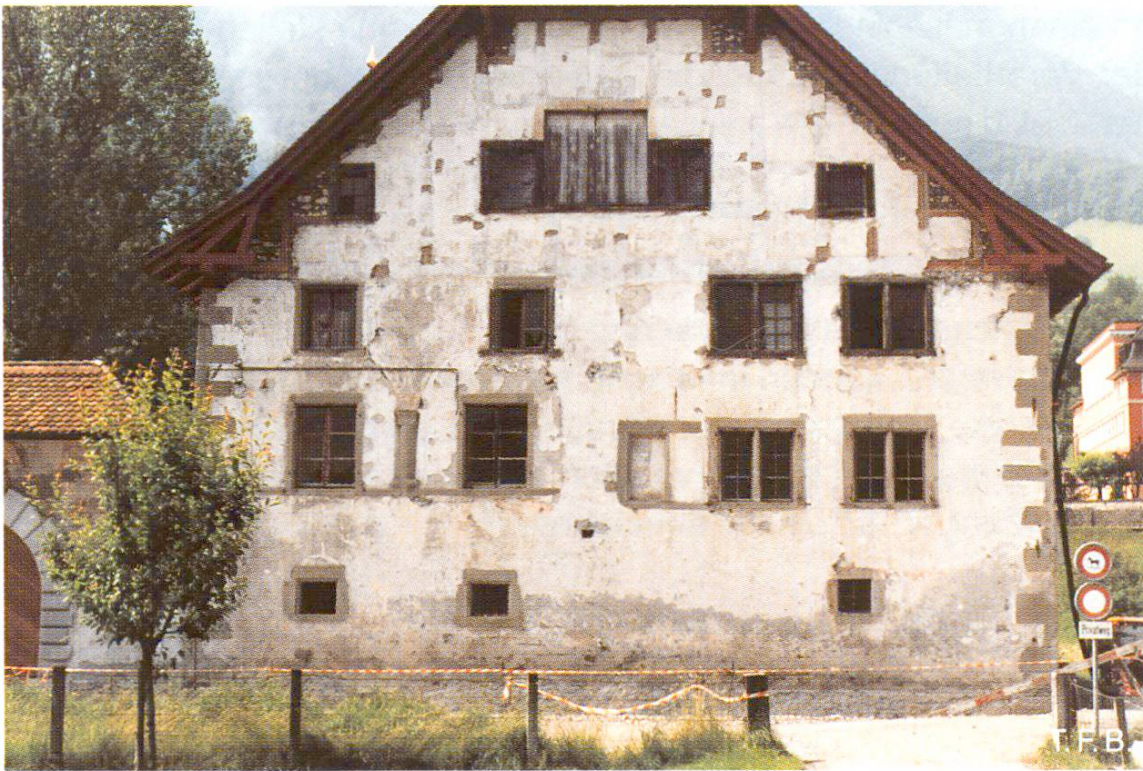
Abb. 2 Deutlich sichtbar ist die vom Fundament her aufsteigende Feuchtigkeit (Winkelriedhaus, Stans, Nordfassade, Juli 1987).
