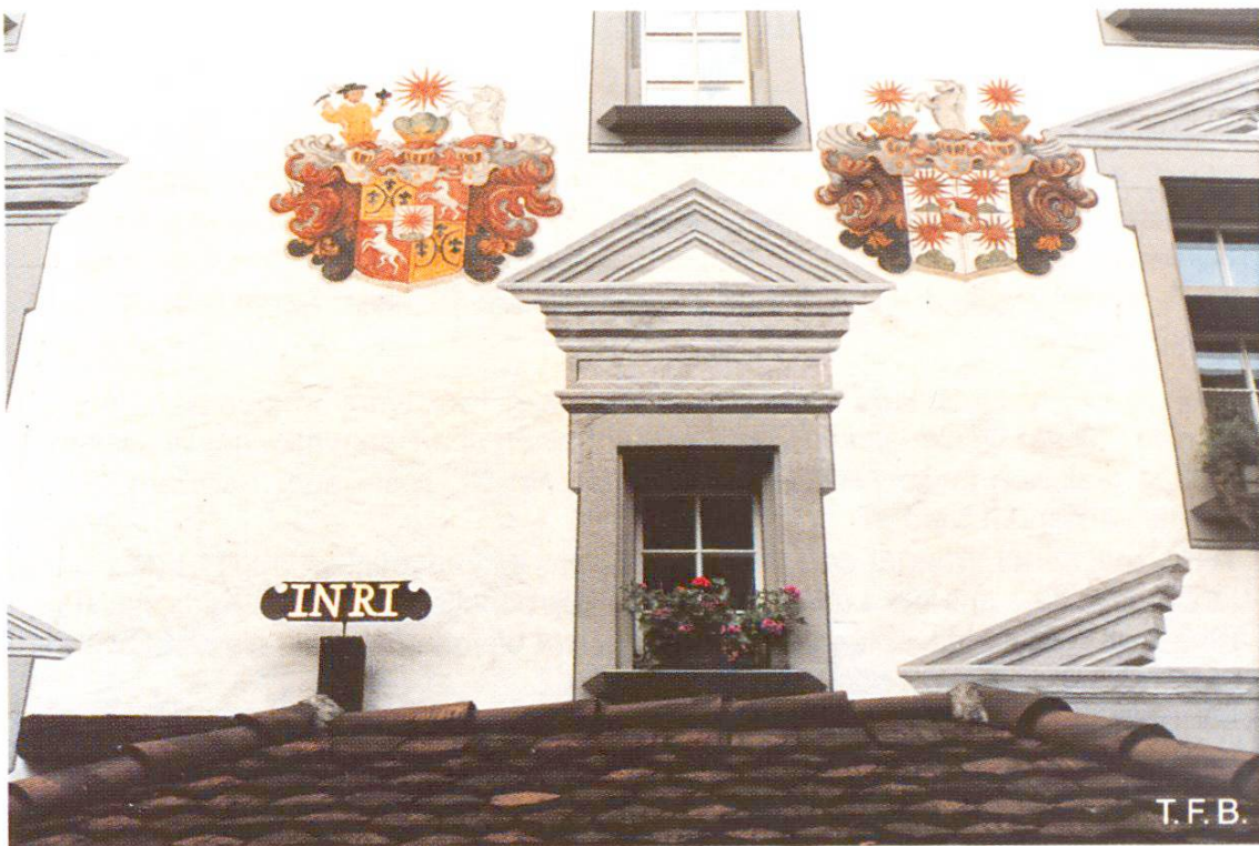
Abb. 4 Vermutlich wurde hier der Grundputz mit der Kelle dressiert bzw. geglättet (Haus zur Liebenau, Luzern).
