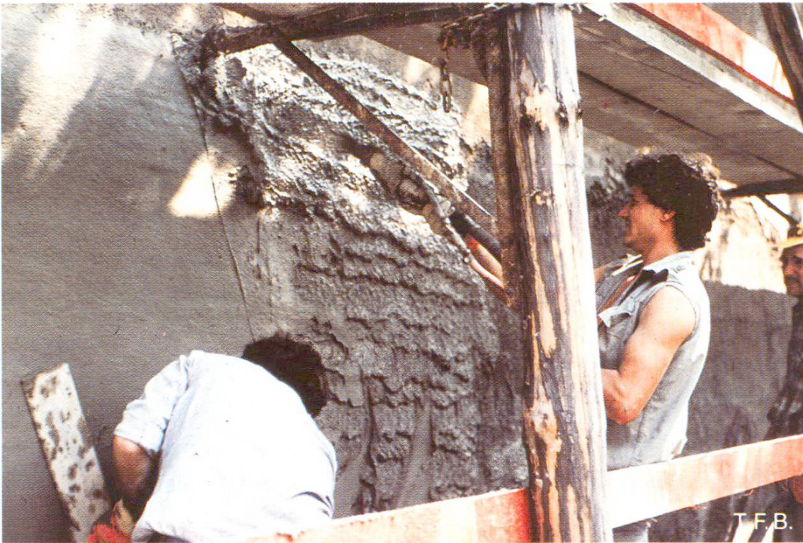
Abb. 6 Renovation einer Fassade mit konventionellem HK-Grundputz (Sand 0–4 mm). Mörtel gepumpt und mit Spritzdüse aufgetragen. Durch Verziehen mit Latte entsteht eine Sinterhaut, die entfernt werden muss.
